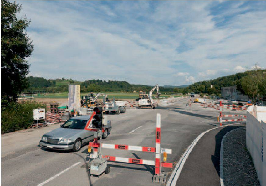
Birmenstorf, Bruggerstrasse/Mooshaldeweg, beim ehemaligen Mövenpick. Hier entsteht einer der 145 Verkehrskreisel, die Ende 2011 in Betrieb sein werden.
