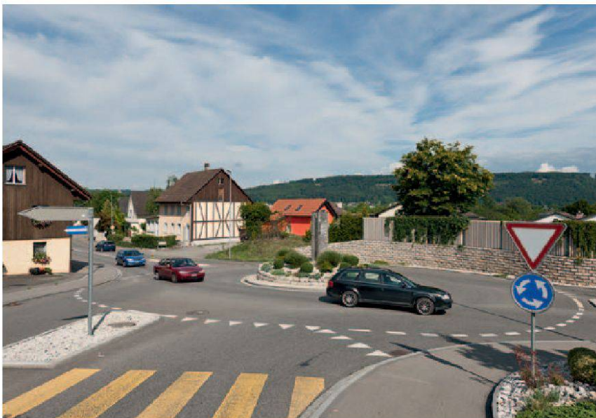
Gebenstorf, Landstrasse/Kinziggrabenstrasse, bei der alten Turnhalle. Der Wasserschlosskreisel in Gebenstorf ist typisch wegen seiner unterhaltsarmen Gestaltung, atypisch, weil er nicht vier Strassen in sich aufnimmt.
