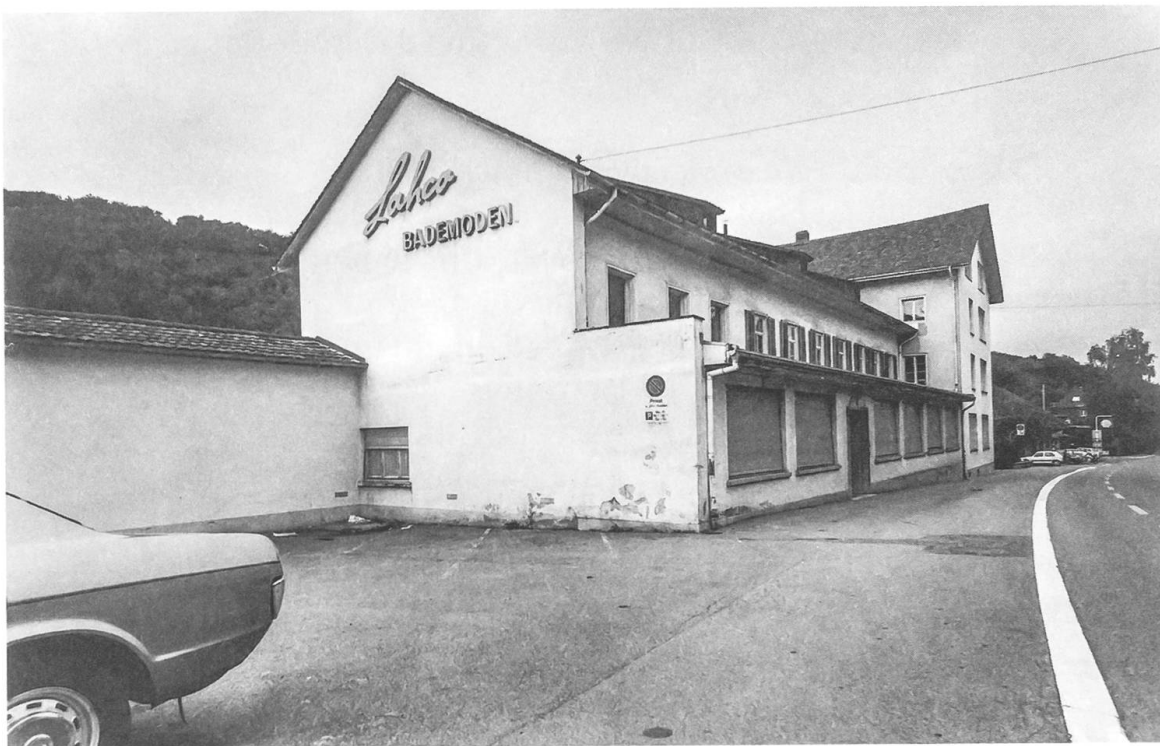
... und kurz vor dem Abbruch im Januar 1986.
