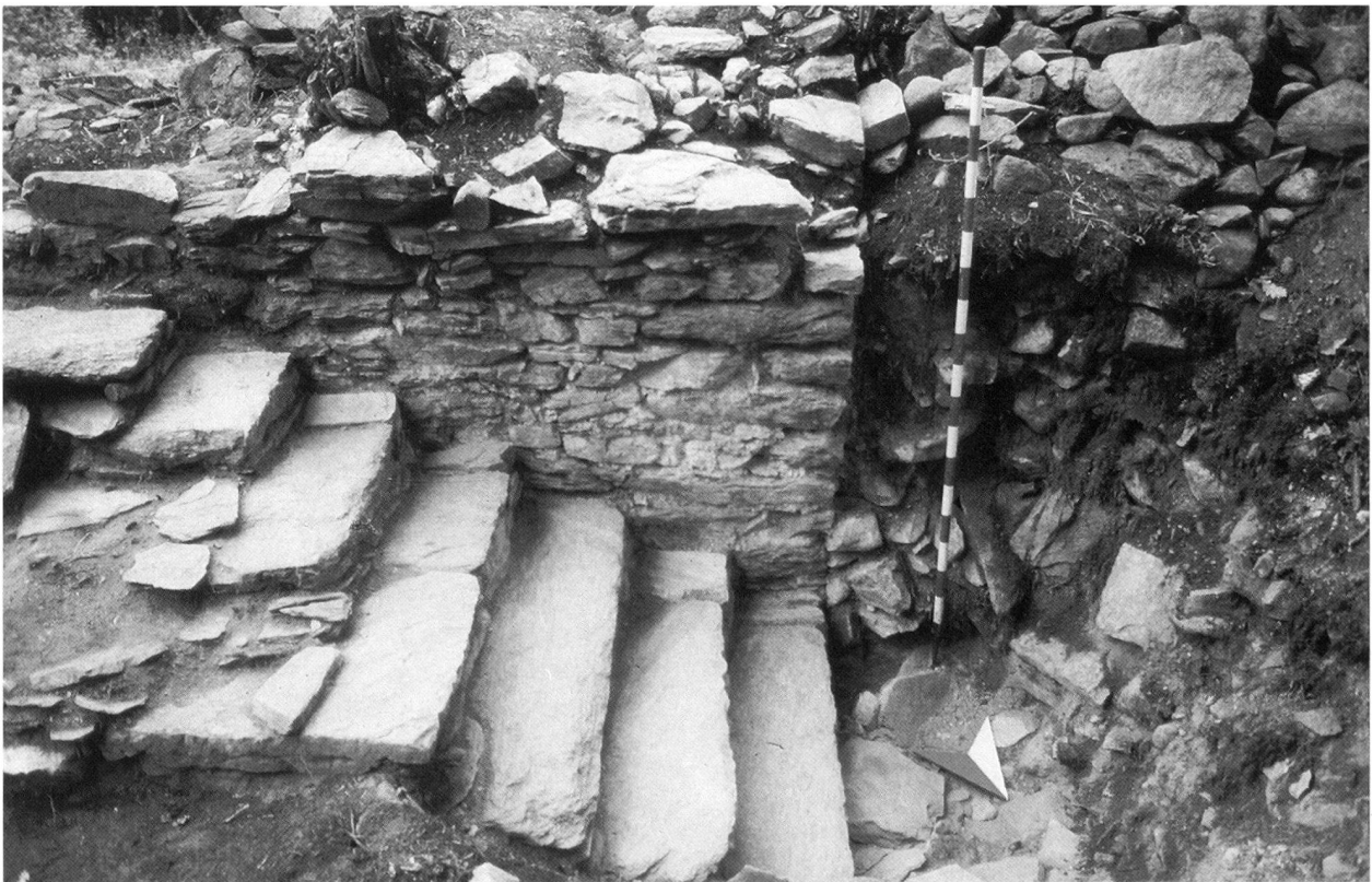
Bironico. La scala addossata al primo edificio (interno della prima cinta muraria).
