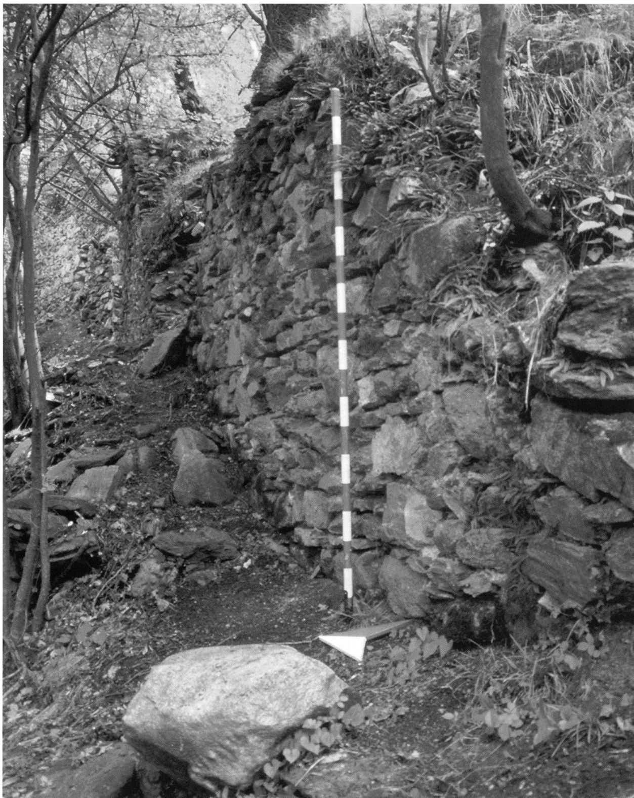
Bironico. I muri della seconda cinta (in primo piano) e della prima cinta.
