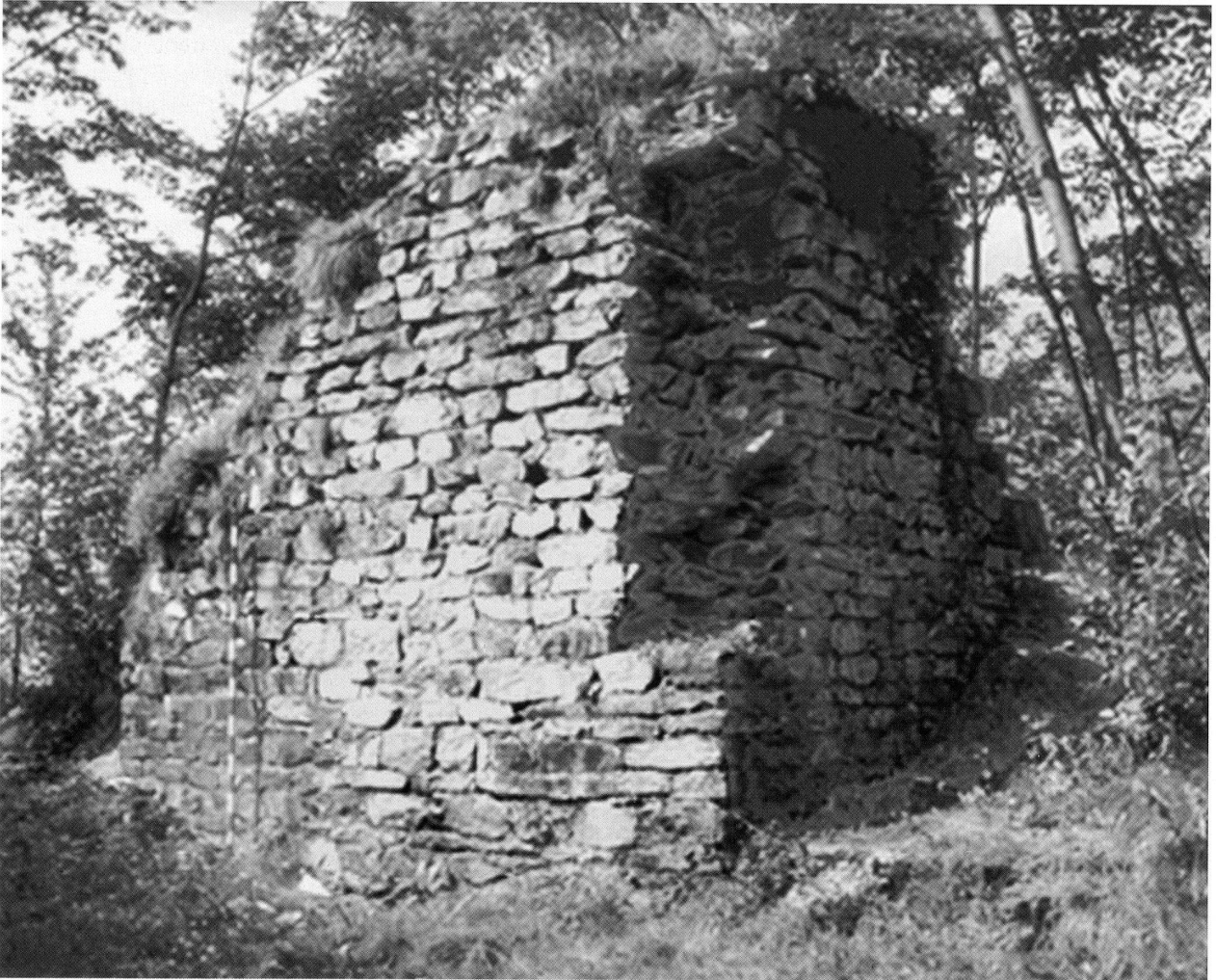
Mezzovico. La torre (da nord-ovest)
