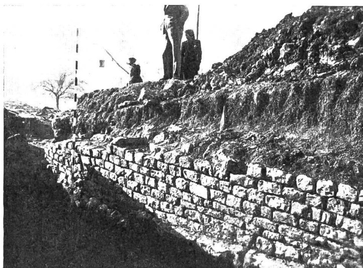
Bild 2. Ansicht der Mauer von Südosten. Photo P. Wolleb, Gelterkinden.
