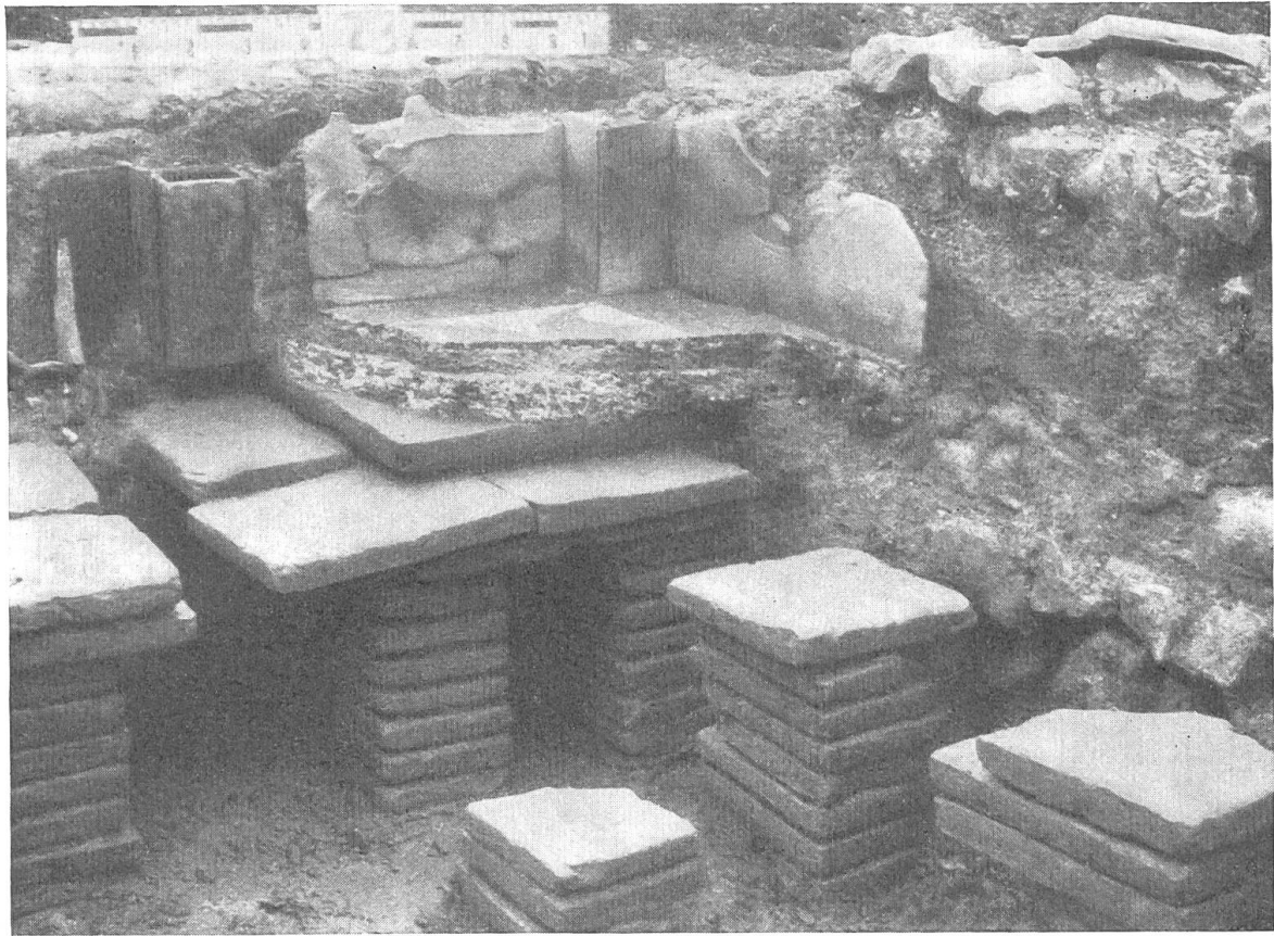
Bild 18. Munzach. Raum E. Südostecke mit Hypokaust. Auf den Bodenplatten Ziegelschrotboden in zwei Lagen mit Mosaik, an der Wand Heizröhren mit Plattenverkleidung.
