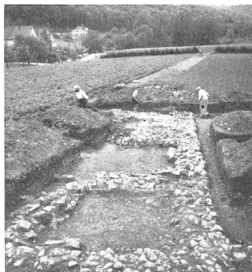
Bild 50. Fundamente eines dreiteiligen römischen Schuppens, der als Werkstätte und Vorratsraum gedient haben mag. Blick gegen Westen. Siehe Bild 1, Raum VI bei der N-W-Ecke des Spitalfriedhofes.
