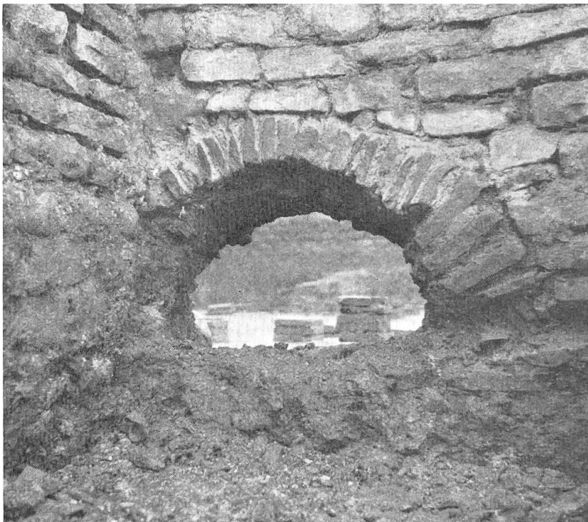
Bild 27. Aus der Südwestecke des Heizraumes U sieht man durch das ausgeflickte Gewölbe der Heizöffnung in den Hypokaust des Wohnraumes S, in dem einzelne Stützpfeilerchen noch teilweise erhalten sind. Unter dem Gewölbe liegt eine 20 cm hohe Aschenschicht. Links die Mauer gegen das Schwitzbad T, dessen Heizung ebenfalls durch ein Ziegelgewölbe aus demselben Heizraum bedient wurde.
