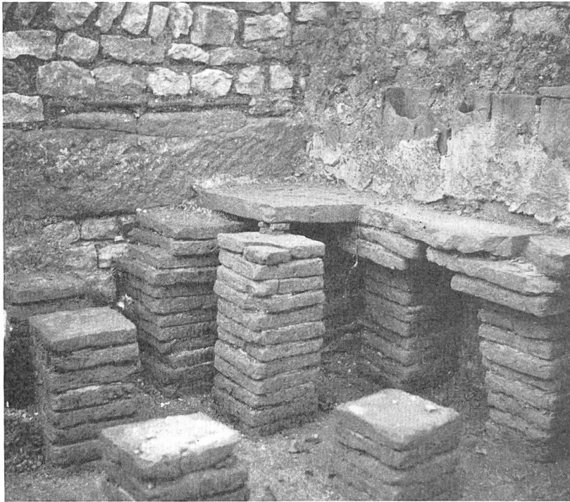
Bild 26. Detail aus Bild 24. Nordwestecke des Schwitzbades, Raum T. Aus 12 aufeinandergeschichteten kleinen Tonplatten werden 60 cm hohe Pfeilerchen gebildet. Darauf ruhen die grossen Bodenplatten. Eine davon liegt in der Ecke des Raumes noch am ursprünglichen Ort. Aus solchen Platten setzte sich der ganze Boden zusammen. Darunter wurde mit Holzkohle geheizt; die Abgase strömten in den Hohlziegeln der Wände (rechts zum Teil noch verputzt) aufwärts und erwärmten sogar das den Raum überdeckende Gewölbe. Links oben die später zugemauerte Türe.
