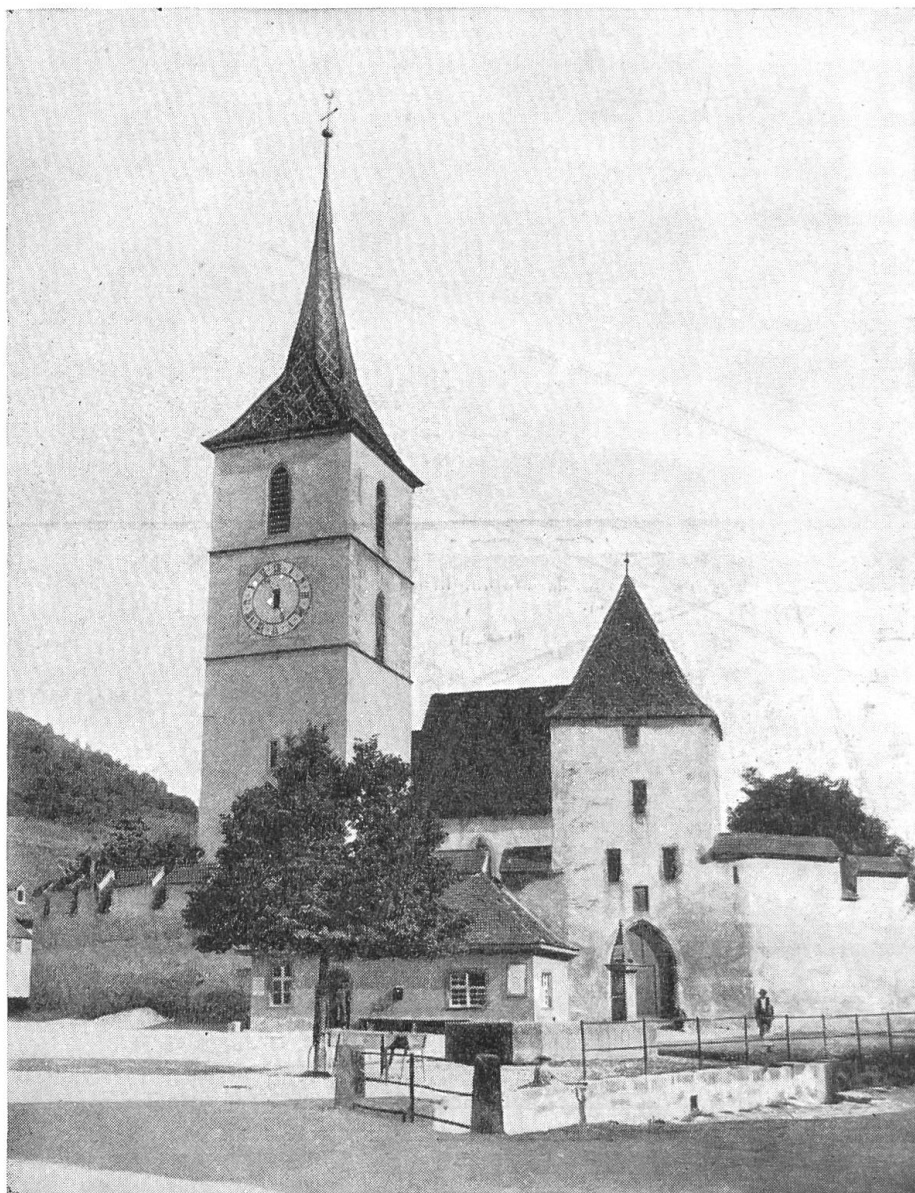
Bild 15. Kirche St. Arbogast. Nordansicht.
