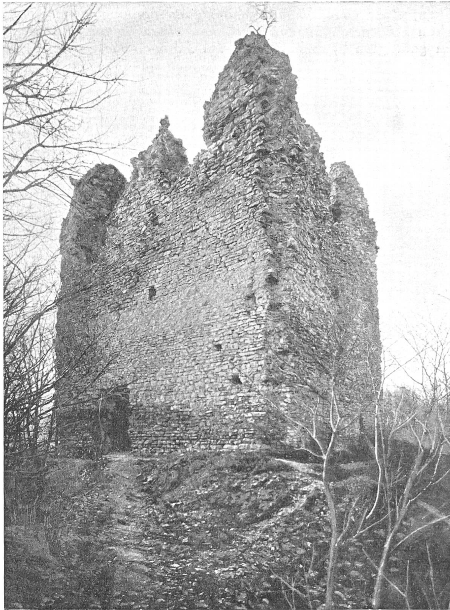
Bild 5. Wartenberg, Mittlere Burg, vor der Restaurierung. Ansicht von Nordwesten.
