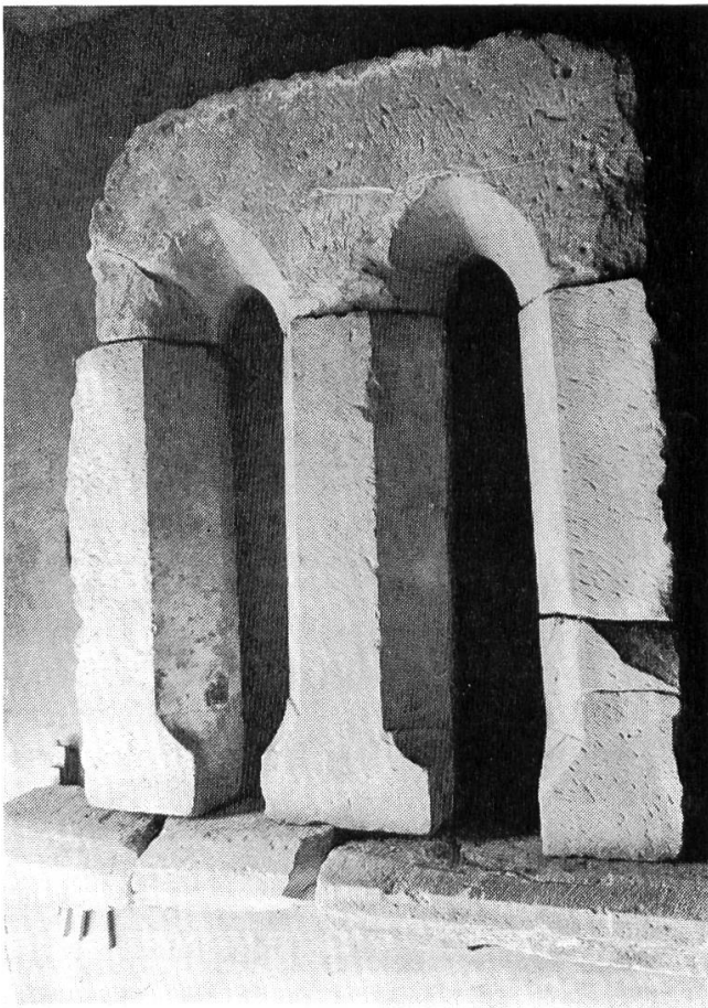
Bild 3. Eines der geborgenen Fenster- gewände.
