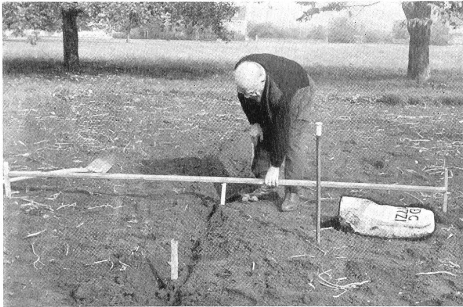
Bild 1. Sicherstellung des Grenzpunktes vor dem Ausheben der Grube. Aus BHB 4, 1948, Seite 149.
