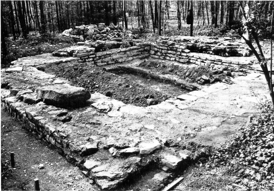
Bild 11. Die Reste des Wachturmes nach der Freilegung 1975, von Südosten. Auf der Süd-mauer links lag noch ein Sandsteinquader ohne Fundzusammenhang. Auf der West- und der Nord-mauer im Hintergrund sind die Balkenlöcher im Kiesel/Mörtel-Gusskuchen noch aus-zumachen.
