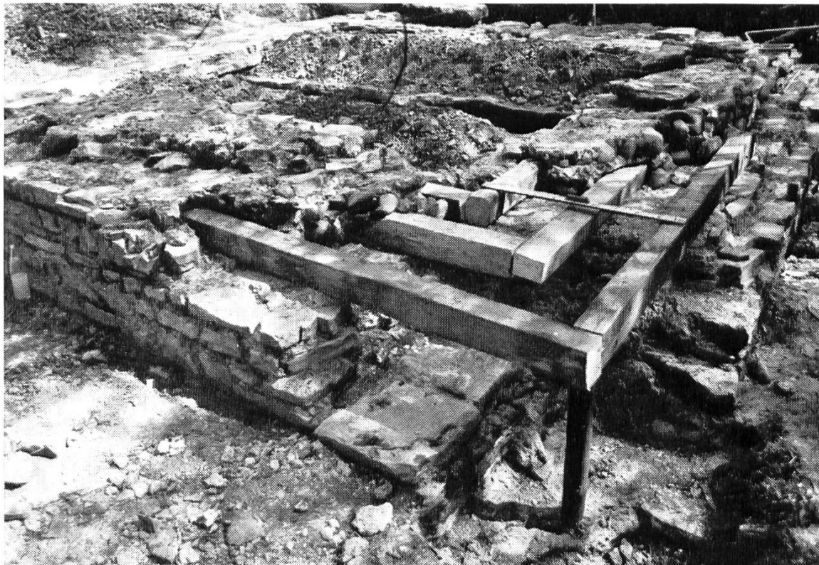
Bild 13. Die Anlage mit der ausgebrochenen Nordwestecke im Vordergrund vor der Konservierung. Zur Veranschaulichung wurden (moderne) Kanthölzer in die Höhlungen geschoben.
