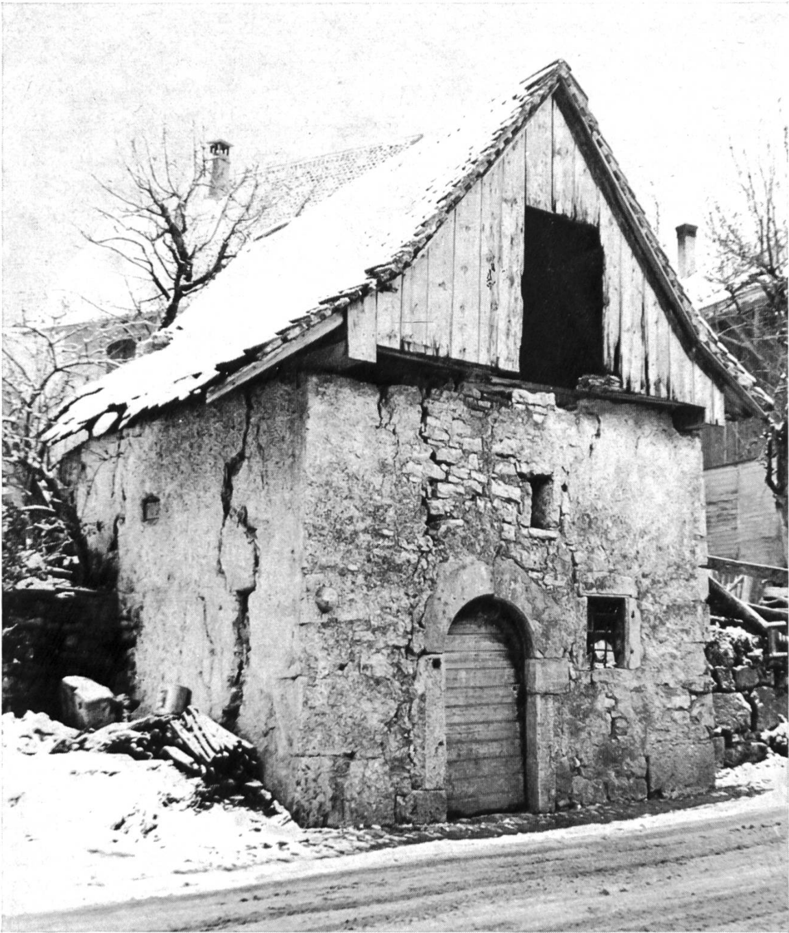
Bild 2. Sodhäuschen südlich des gleichnamigen Restaurantes, Zustand vor der Renovation. Photo A. Weber.
