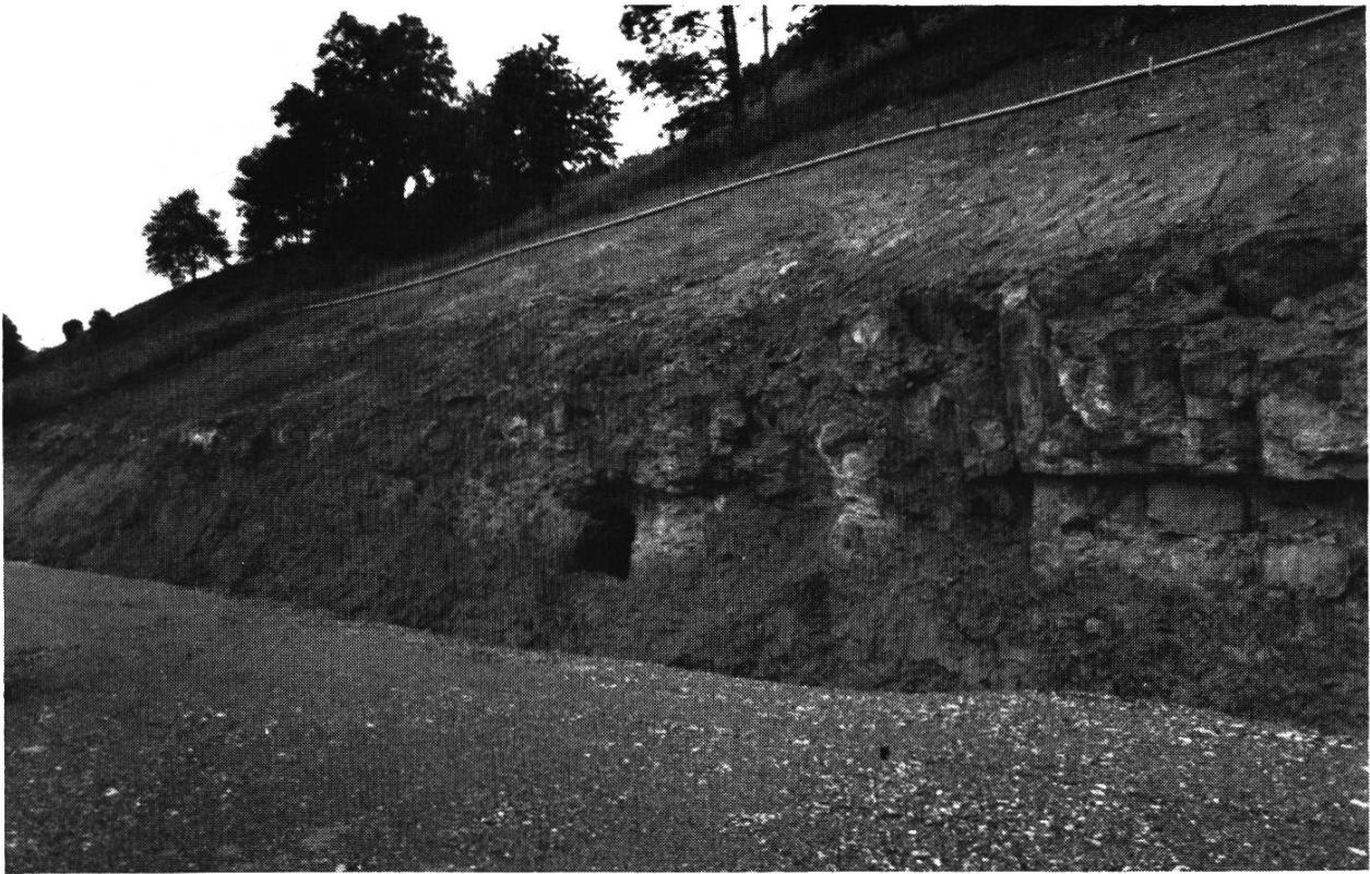
Bild 1. Stollen unterhalb Bad Bubendorf, am Talrand, in den horizontal gelagerten Schichten des Unteren Doggers.
