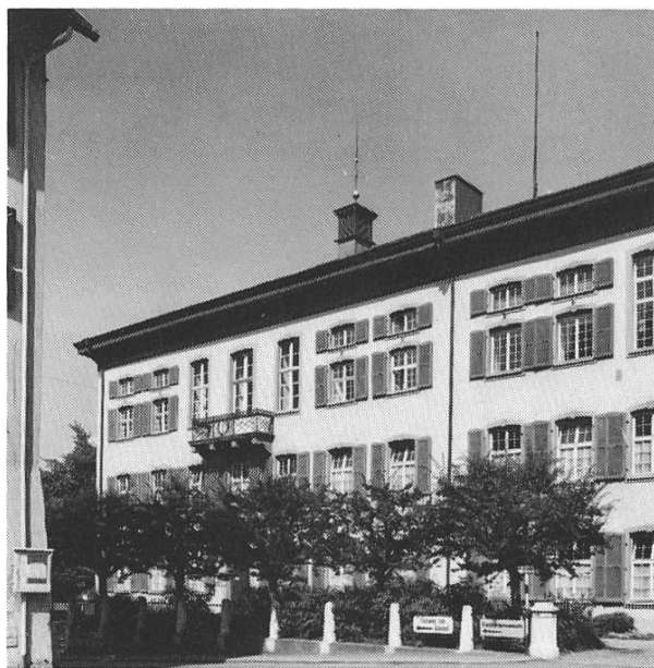
Bild 14. Der 1853 errichtete West- oder Archivflügel des Regierungsgebäudes.
