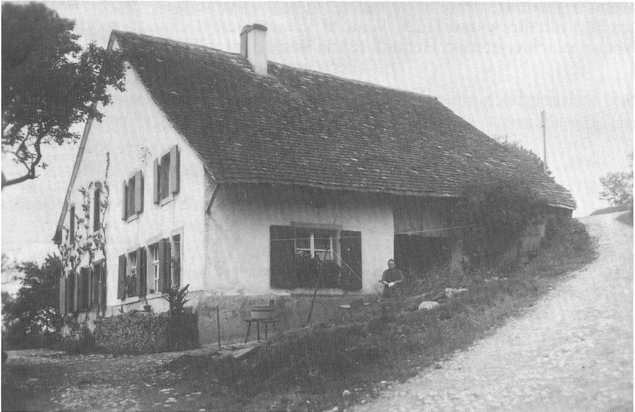
Abb. 6. Die umgebaute Verenakapelle um 1940. Steiles Satteldach mit leichtem Knick (Würgi). Oekonomie auf der Bergseite, daselbst Eingang in den Wohnteil Schaub. Photo Fritz LaRoche.
