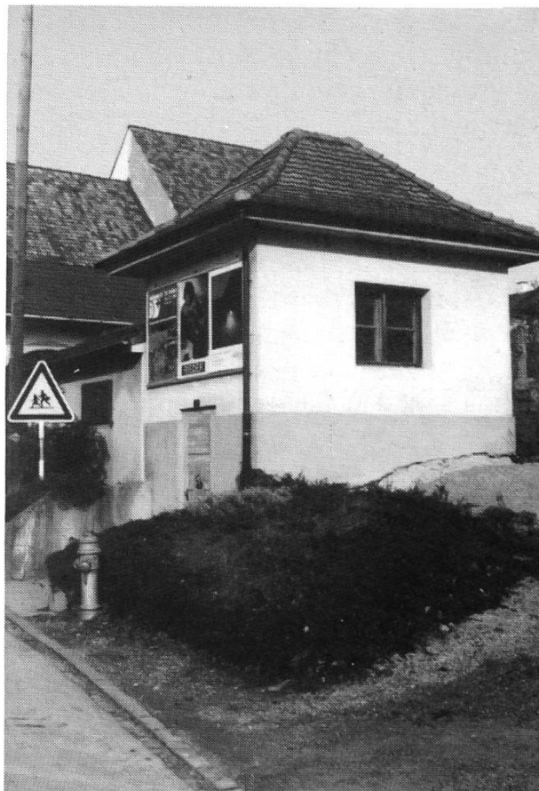
Das Pumpenhaus, erbaut 1932, ermöglicht auch den obersten Dorfliegenschaften die Versorgung mit Oberdörfer Wasser.
