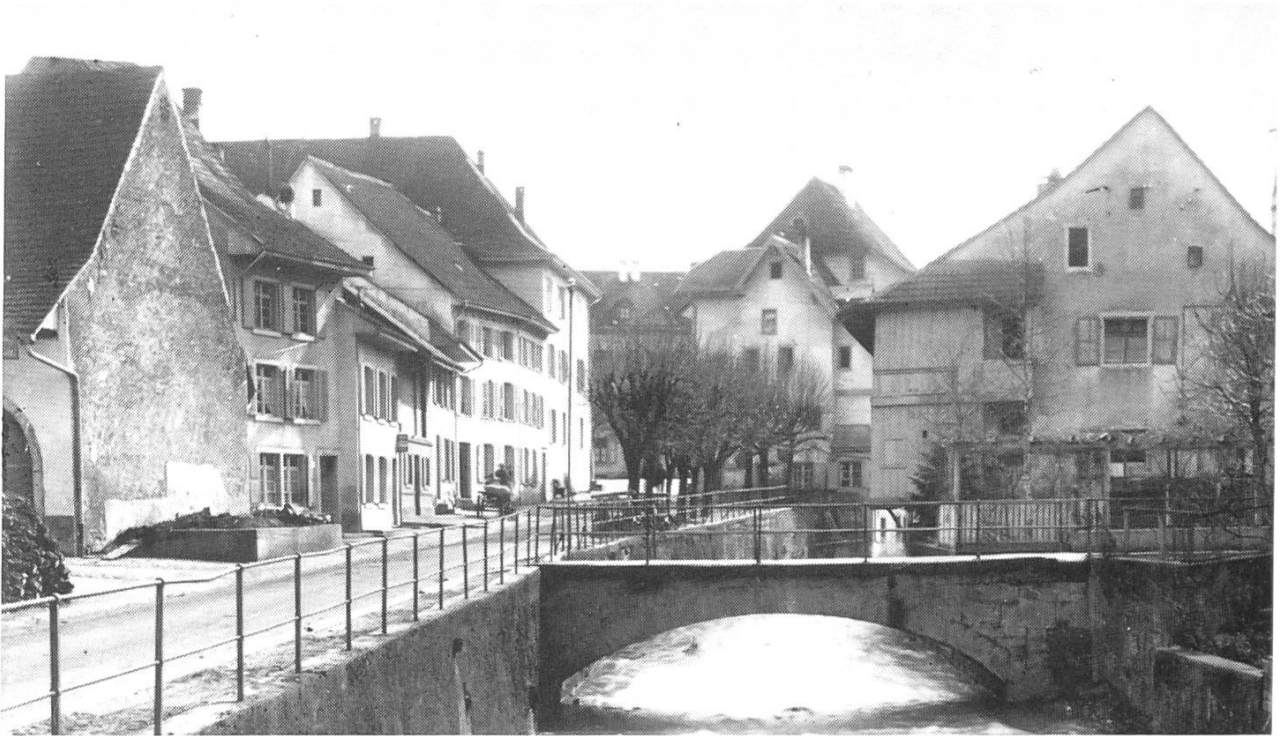
Die alte «Eidgenossenbrücke», in Naturstein ausgeführt.
