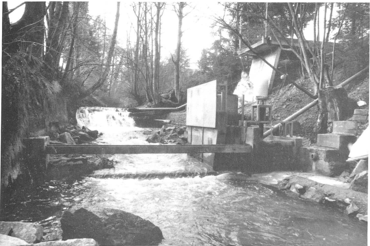
Der Giessen «Steinengumpi» mit der Installation für die Kunsteisbahn.
