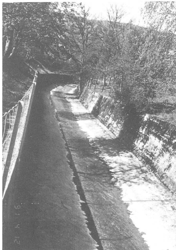
Die Bachverbauung unterhalb der «Schliffbrücke» (Zustand 1992).
