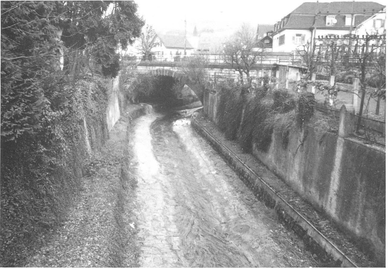
Die architektonisch ansprechende Eisenbahnbrücke, erbaut 1853.
