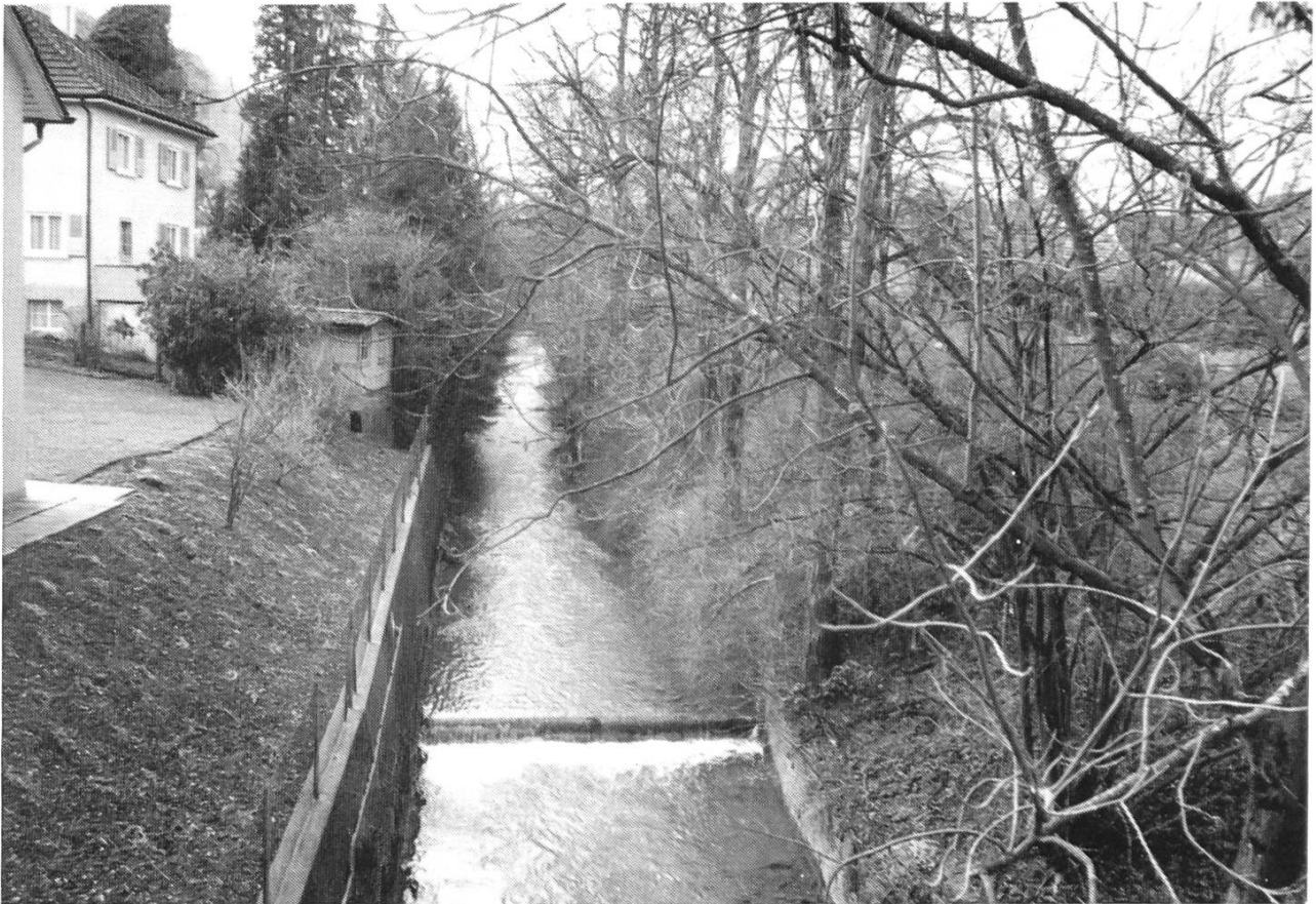
Der Zunzgerbach oberhalb der Sägebrücke: links Ufermauer, rechts gut bewachsenes Uferbord.
