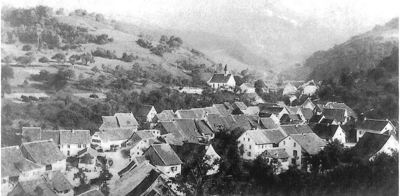
Abb. 2: Reigoldswil um 1880, Ansicht von Nordwesten. Das elterliche Haus befindet sich ganz rechts über dem Bildrand. (Älteste bekannte fotografische Dorfansicht; die Kirche hat noch den alten Turm).
