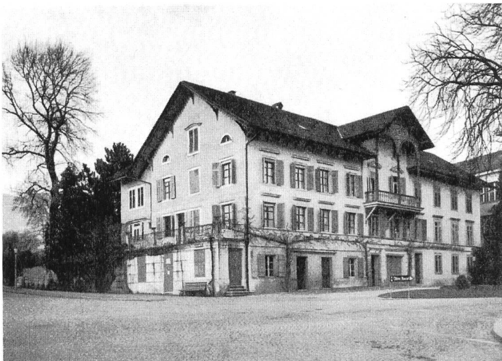
Abb. 17: Solothurn, die alte «Schanzmühle» an der Werkhofstrasse.
