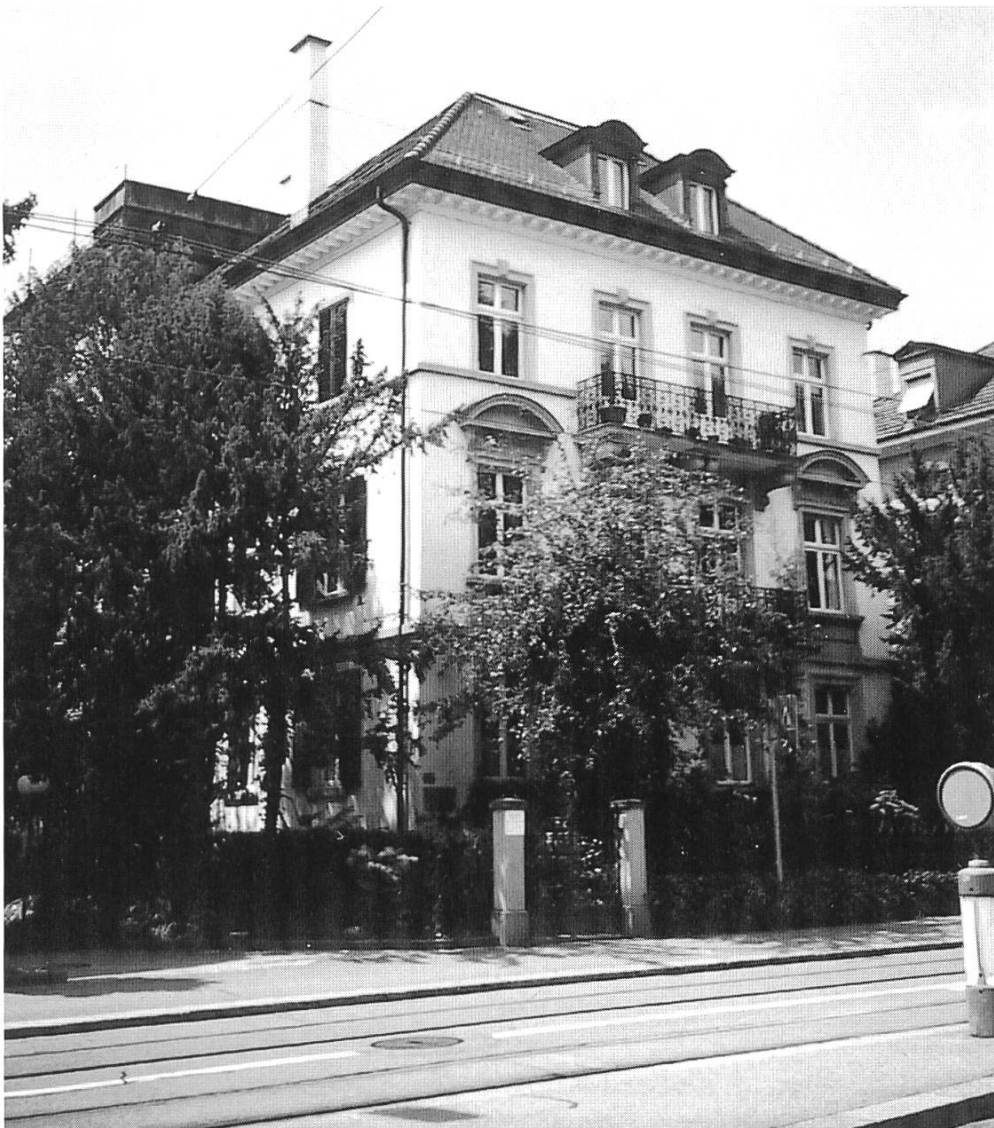
Abb. 24: Zürich, Wohnhaus Schweizers an der Weinbergstrasse (Aufnahme von 1998).
