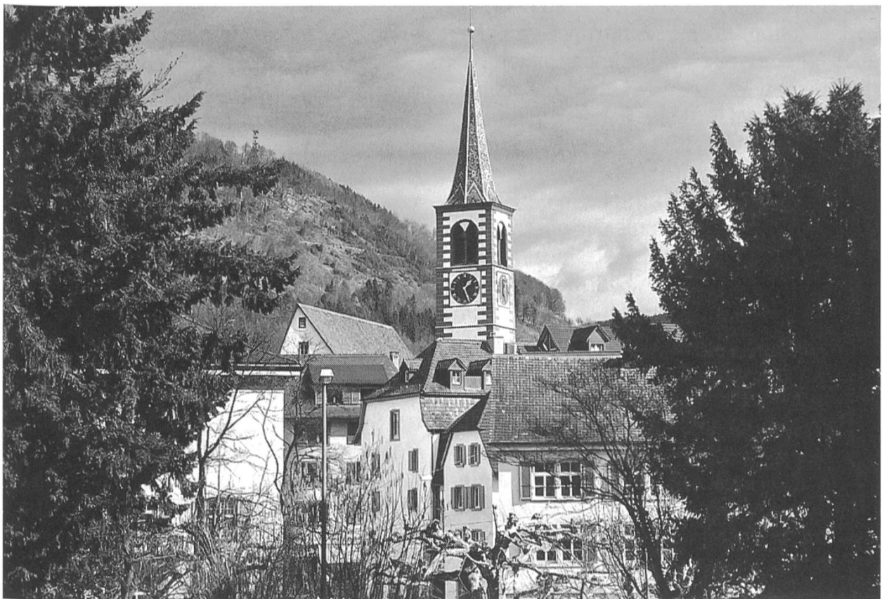
Abbildung 6: Kirchturm nach der Renovation mit der wieder aufgetragenen, ursprünglichen Dekorationsmalerei. (Kant. Denkmalpflege)
