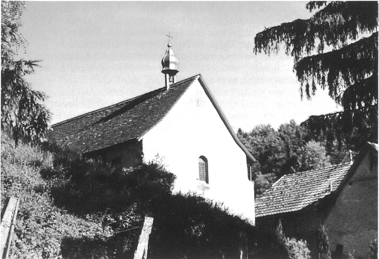
Die Wartkapelle ist an eine abschüssige Halde gebaut.
