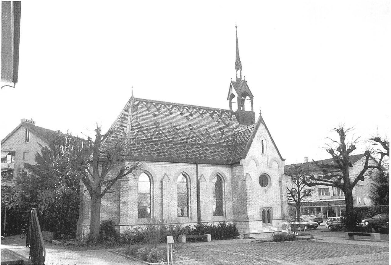
Abb. 4: Ref. Kirche Allschwil: Nordseite.
