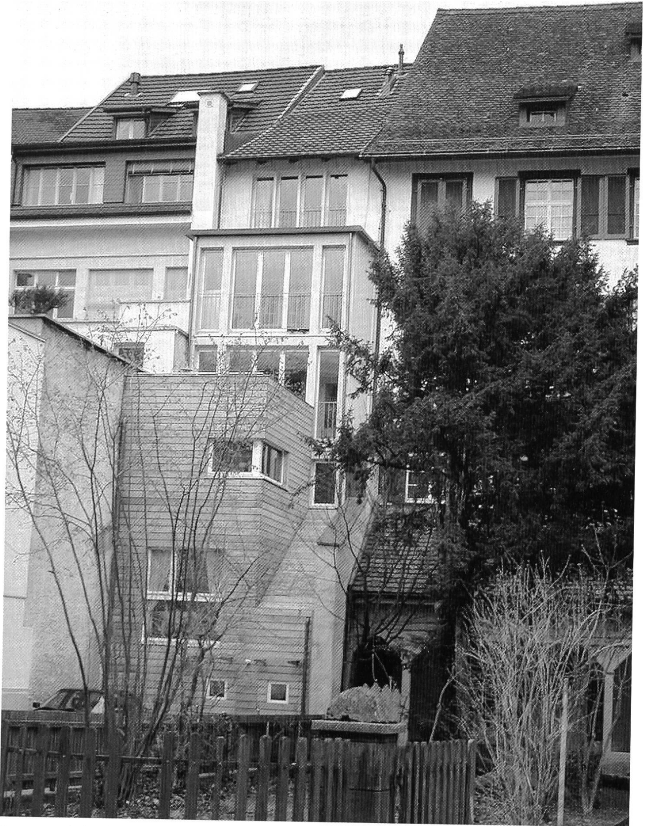
Erneuerter Anbau im Bereich des Stadtgrabens.
