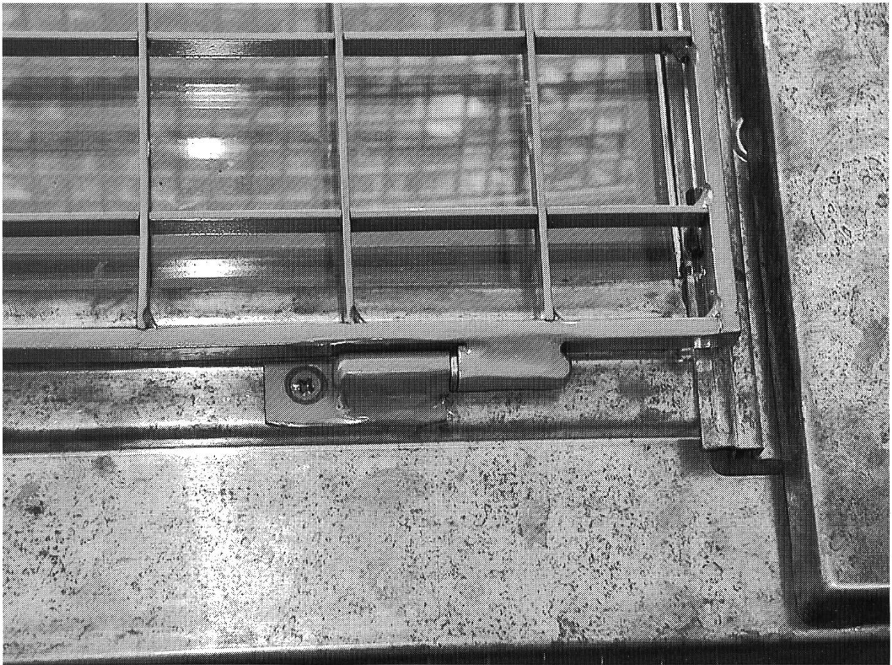
Detailaufnahme Dachfenster «Typ Ortskern».
