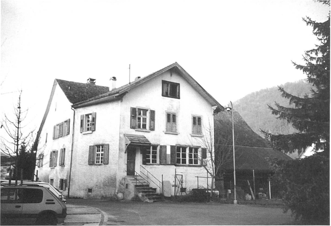
Abb. 5: Ansicht von Südwesten im März 1998. (Foto M. Thommen, Sissach)
