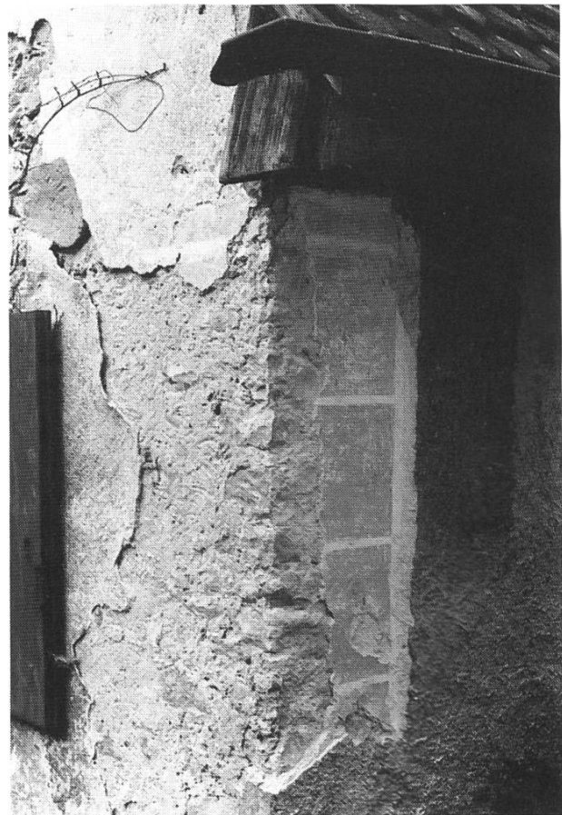
Abb. 10: Arlesheim, Gärtnerhaus der Ermitage, Eckquadrierung, Befund an der Südostecke.
