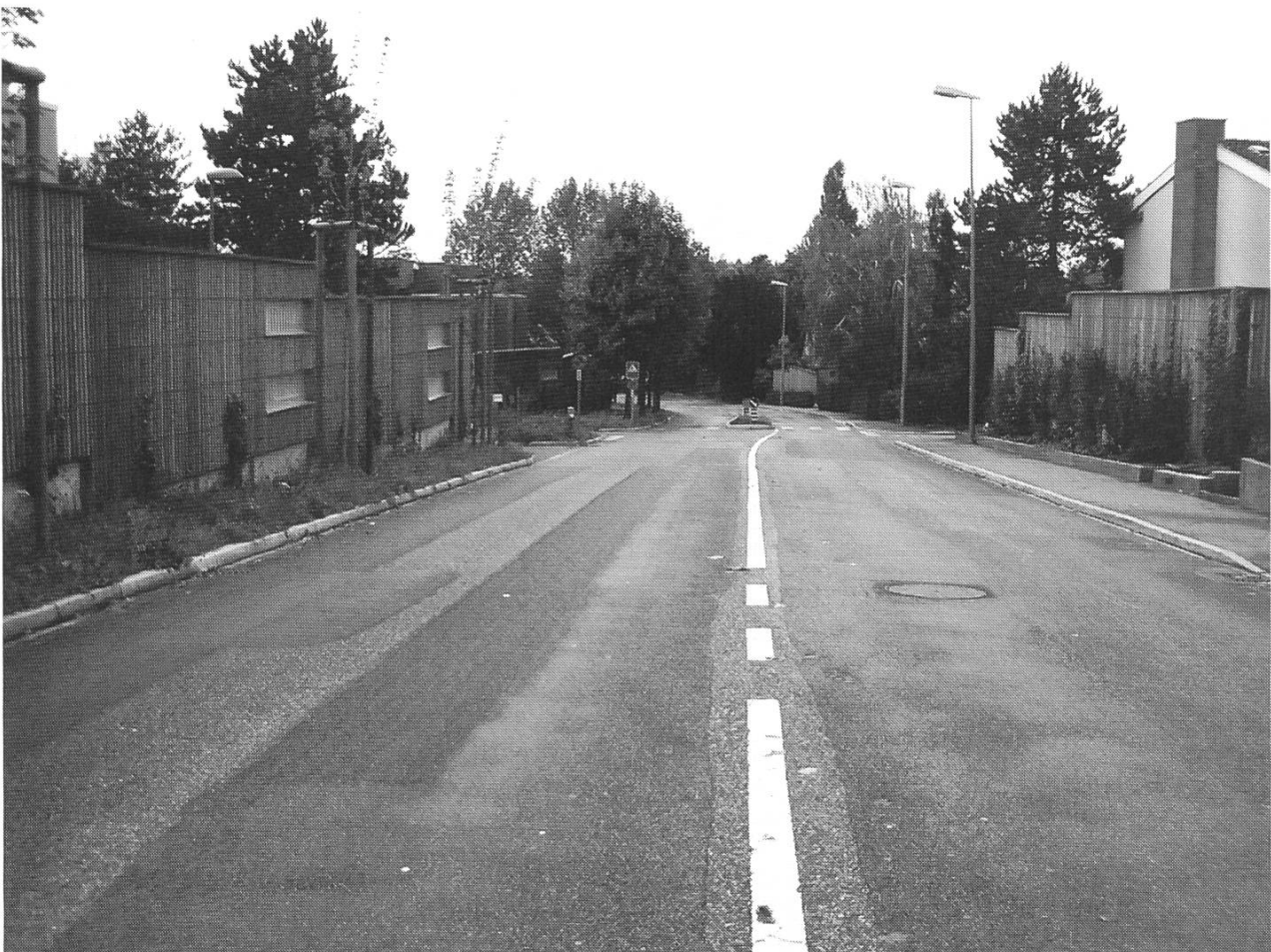
Abb. 14: Bottmingen: Beidseitige Schutzwände engen Sichtfeld ein.
