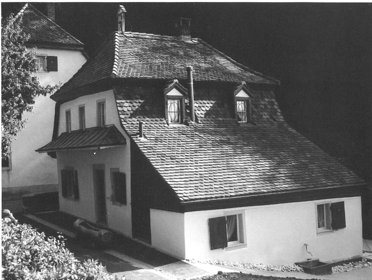
Abb. 7: Arlesheim, Gärtnerhaus der Ermitage, nach der Sanierung.
