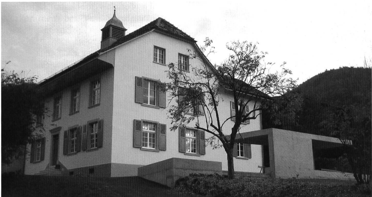
Abb. 23: Nach dem Umbau mit neuer Pausenhalle.
