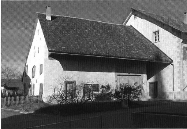
Strassenfassade nach der Sanierung.
