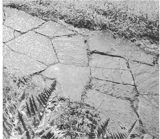
Steinplattenweg mit bewachsenen Plattenfugen.
