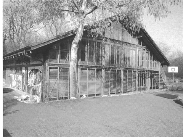
Jugendzentrum Burgstrasse 95, Reinach (R. Senn/ F. Meier, Architekten Basel).
