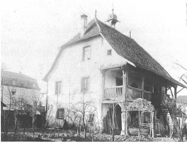
Ostfassade mit Laube vor und nach der Sanierung.
