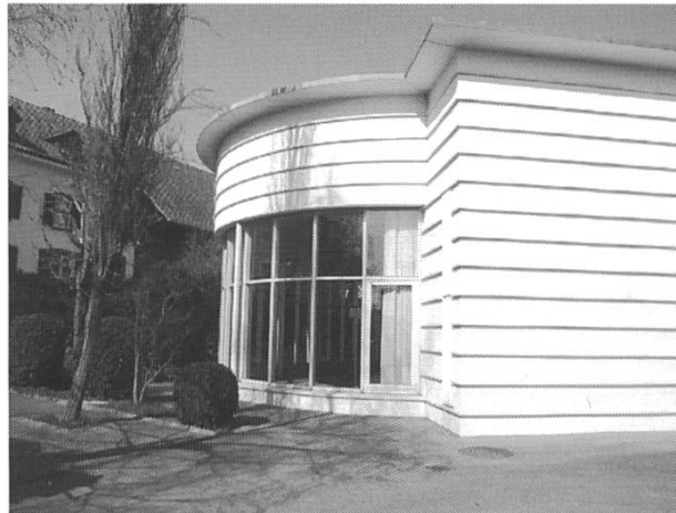
«Kronenmattsaal» Binningen (R. Meyer & F. Schmidlin, Architekten Basel).
