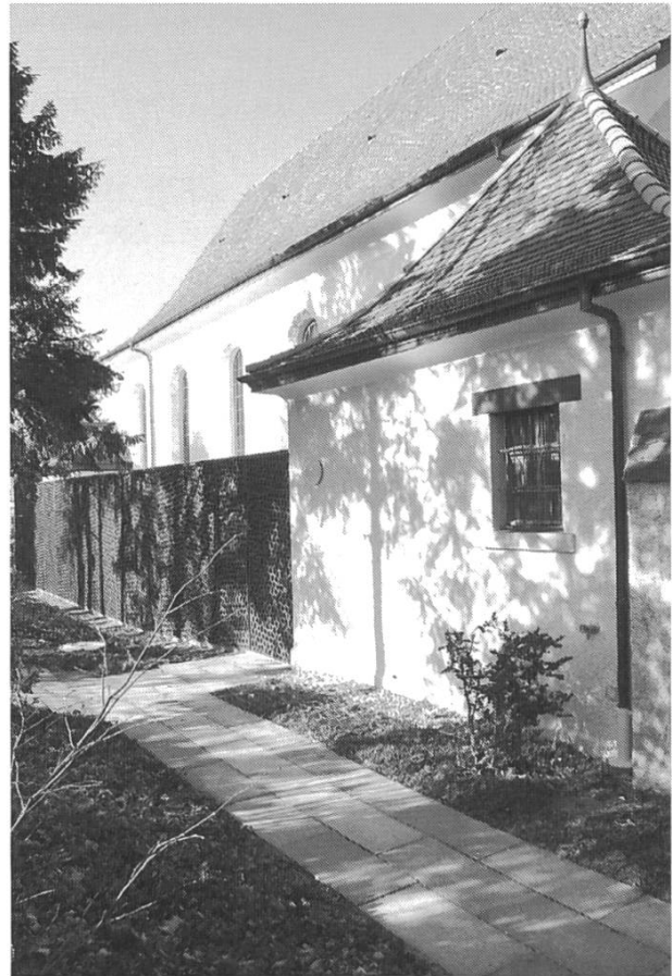
Der neue Anbau auf der Südseite der Kirche.
