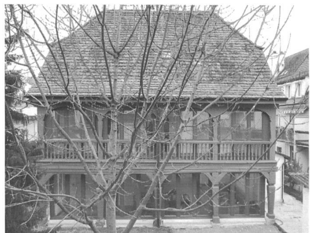
Die sanierte Laube in Frontalansicht.
