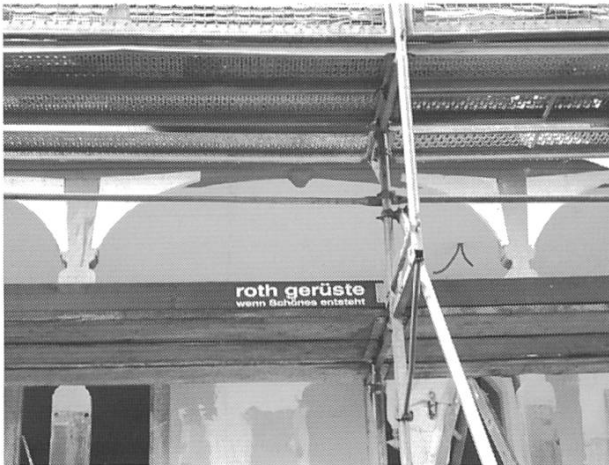
Obergeschoss der Laube mit ergänzten Kopfbrettern.
