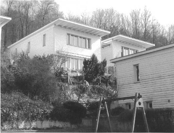
Wohnsiedlung «Im Link», Münchenstein (Zwimpher und Partner, Architekten Basel).
