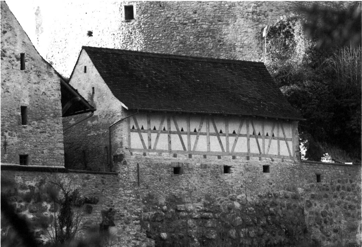
Arlesheim, Schloss Birseck: Sanierte Umfassungsmauer mit rekonstruiertem Schopf.
