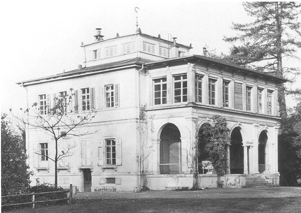
Abb. 1: Villa Ehinger vor der Sanierung von 1972, ca. 1967.
