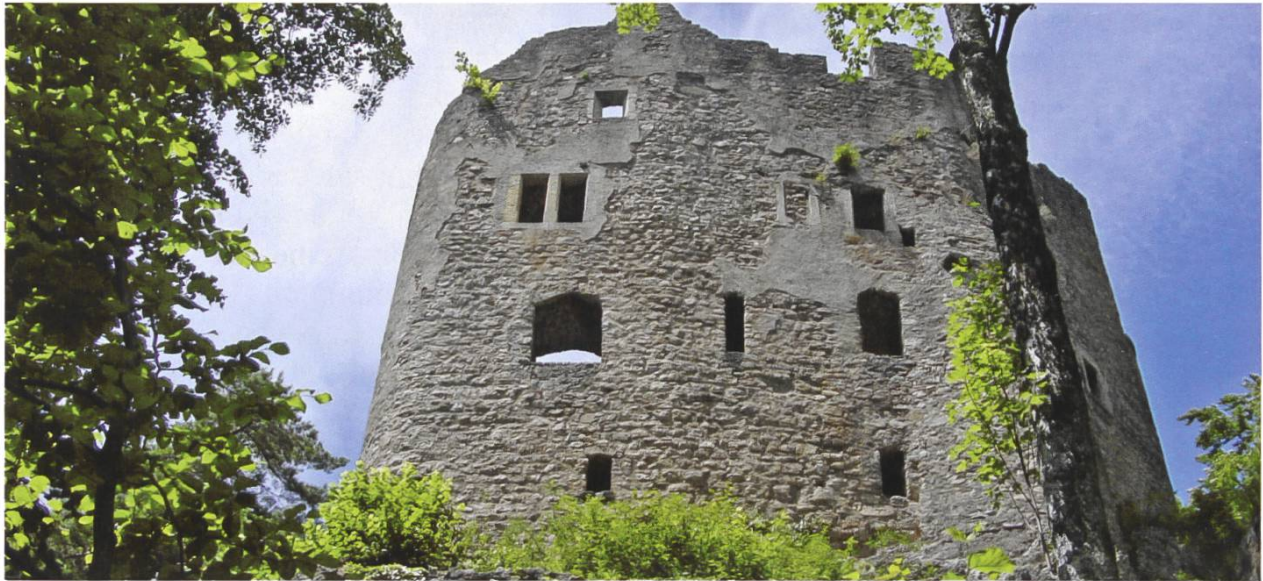
Abb. 2: Einfach nur da oder ein Denkmal der Geschichte? Die Homburg vor der Renovation. Foto Martin Stohler, Basel. Aufnahme wahrscheinlich im Sommer 2007.
