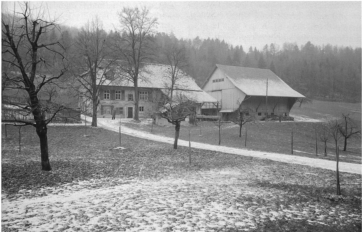
Abb. 3: Der Hof Talacker, von Süden (Foto 1954 von Arnold Seiler), StABL PA 6292. Im Hintergrund ist der Hügelszug des Ostenbergs zu sehen. Hinten rechts lag der gleichnamige Bauernhof.
