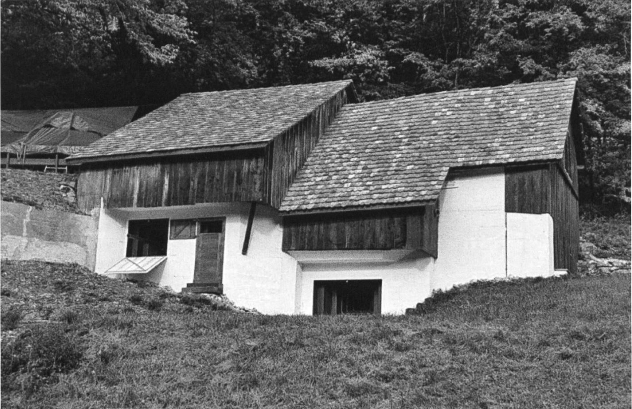
Bild 19: Der als Tenn und Stall getarnte Bunker Ost der Sperrstelle Diepflingen, erbaut ab Anfang Oktober 1938 bis Juli 1940. Linke Öffnung für die Panzerabwehrkanone, rechte Öffnung für das Maschinengewehr. Umrüstung auf 9 cm Pak 50/57 im Jahre 1965. 1984 Demontage der Bewaffnung und Ausserdienststellung. Seit 2017 renoviert, Wiedereinrichtung der militärischen Infrastruktur und betrieben durch den Bunkerverein Diepflingen. (Bild: Bkr Verein Diepflingen)
