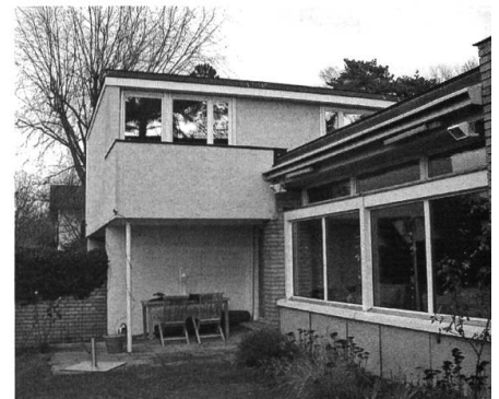
Wohnhaus Wirzenweid Zürich (1956–57), erhielt 1961 die «Auszeichnung für Gute Bauten in der Stadt Zürich», Aufnahme 2007 (Foto: Daniel Walser)
