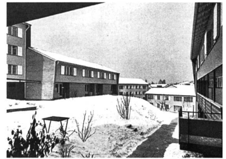
Städtische Wohnsiedlung Manegg in Zürich-Wollishofen (1954/55), Differenzierte Aussenräume zwischen den zweigeschossigen Laubenganghäusern (Werk, Heft 1, 1957, S. 15)
