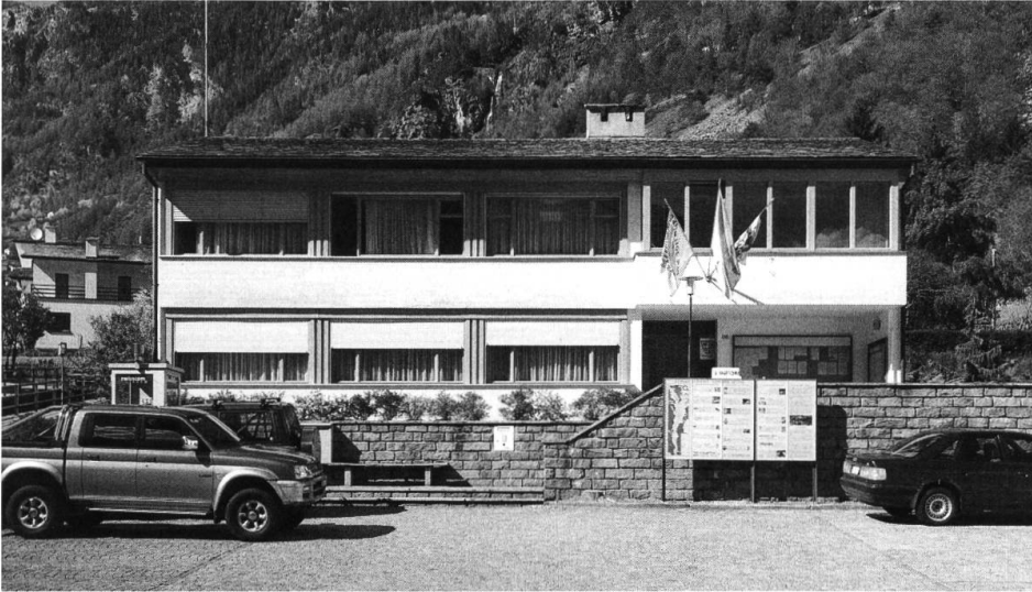
Gemeindehaus Brusio, 1959–1962, Bruno Giacometti, Eingangsseite – als Gegengewicht zu den Auskragungen mit den Archivschränken auf der Nordseite tritt zur Strasse hin jener Saal als Erker hervor, wo der Gemeindevorstand tagt (Foto: Ralph Feiner).
