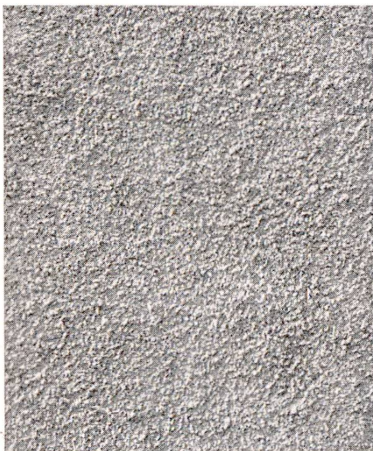
Enduit bien exécuté (rusticage à la truelle)
