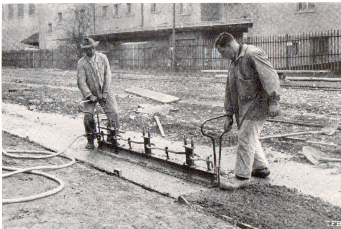
Fig. 1 Vibration superficielle au moyen du «Vibropil» lors de la construction d'une route en béton à la gare-marchandises de Zurich. Direction des travaux : Routes en béton S. A., Wildegg. Exécution : Prader et Cie., S. A., Zurich.
