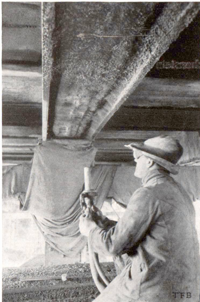
Fig. 3 Gunitage des membrures inférieures
