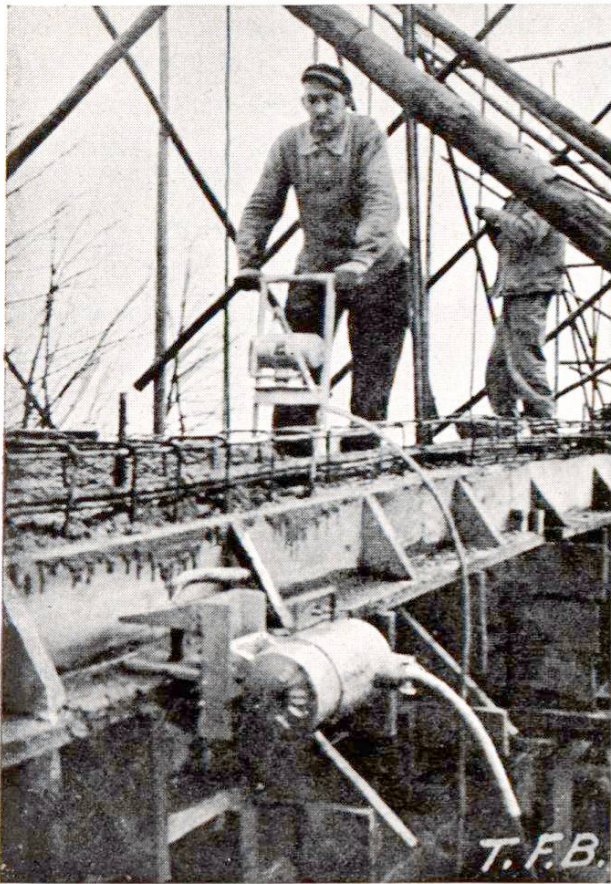
Fig. 2 Vibration externe au moyen d'une fourche vibrante et d'un vibreur électrique fixé sur le coffrage latéral.
