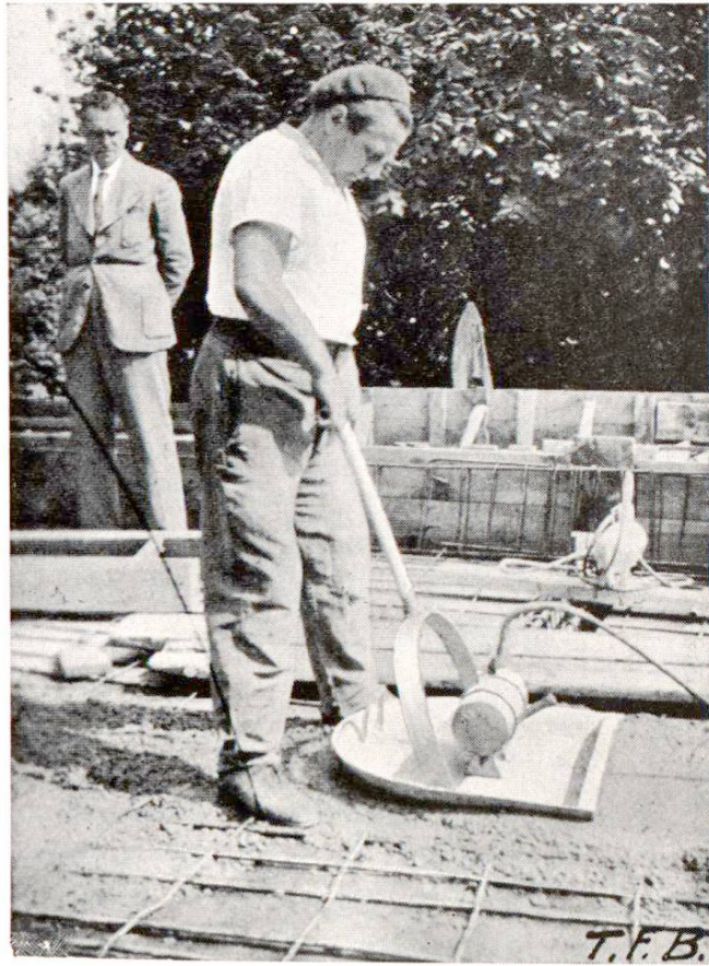
Fig. 3 Vibration superficielle au moyen de la pelle vibrante.
