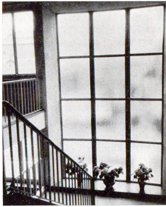
Fig. 4. La grande fenêtre avec châssis en béton armé, dans la cage d'escalier.
