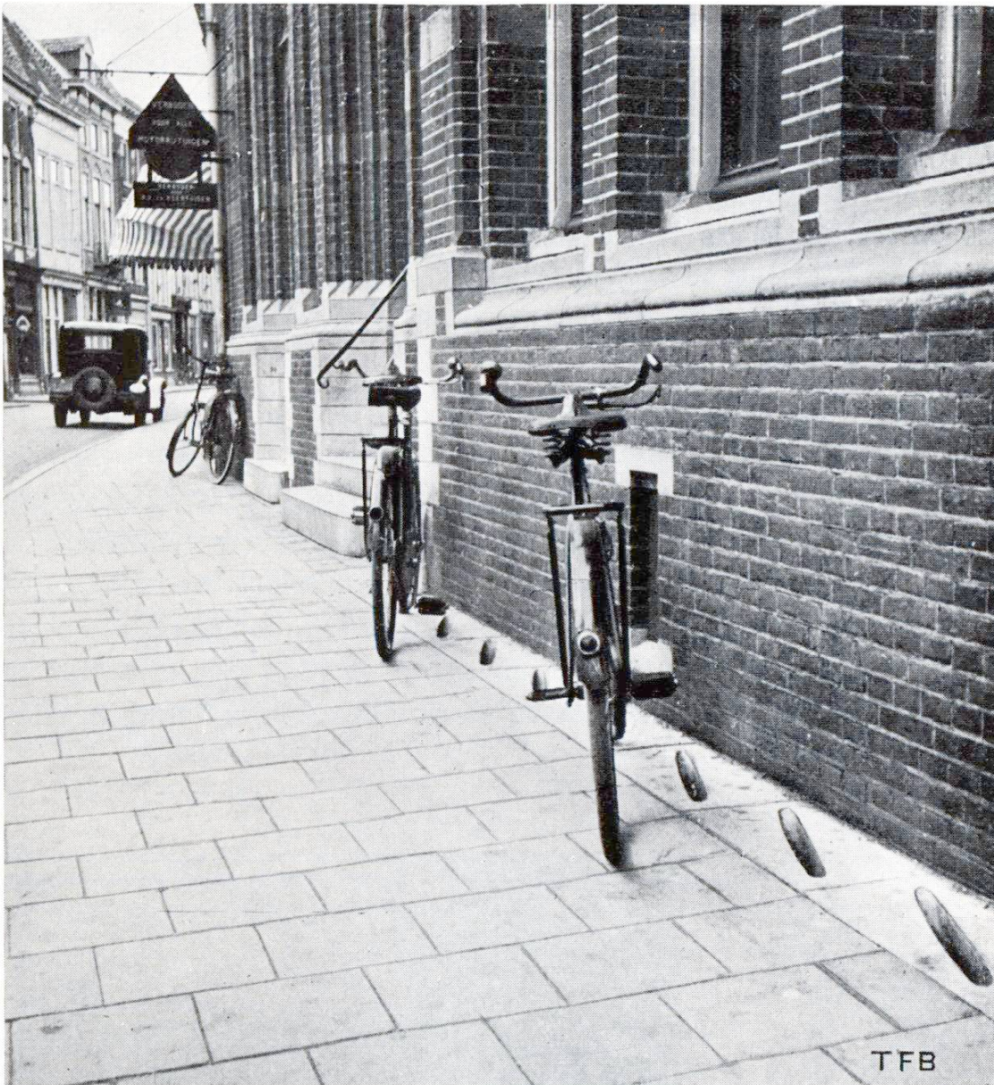
Fig. 7. Plaques en béton pour le stationnement des vélos.
