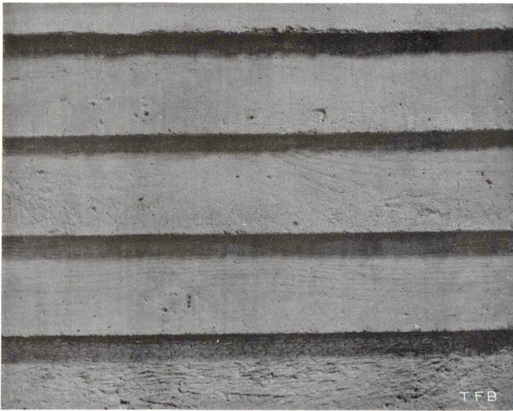
Fig. 2 Béton de parement obtenu avec un coffrage à recouvrement. Laissé brut
