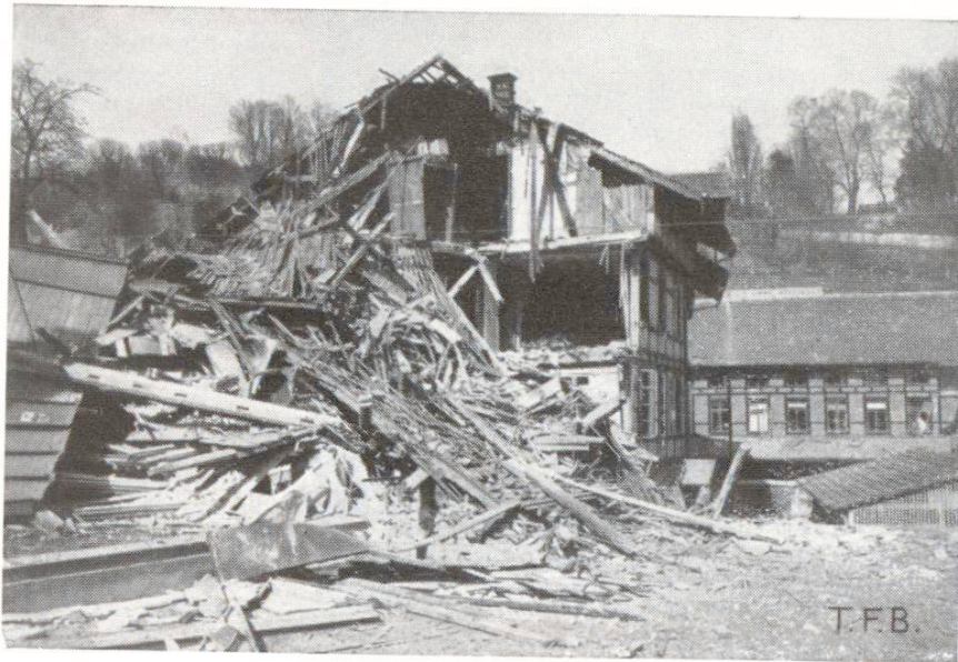
Fig. 3 Effet de l'explosion sur une construc- tion en colombage maçonnée
