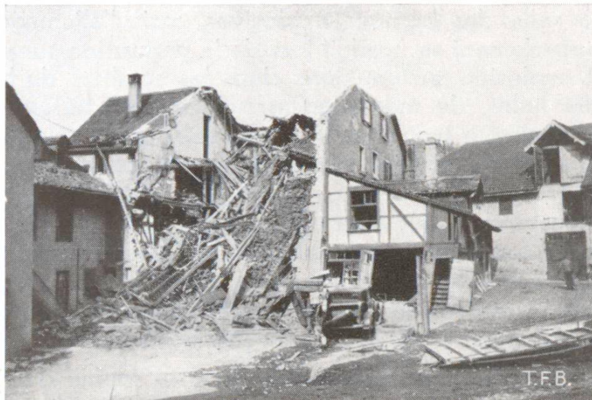
Fig. 2 Effet de l'explosion sur une maison d'habitation. Maçonnerie en moellons et en briques de terre cuite
