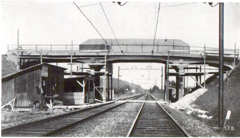
Fig. 11 Réparation d'un pont en béton armé
