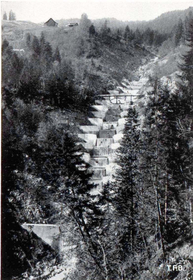
Fig. 6 Escalier de barrages en béton à déversoirs revêtus de pierres naturelles. Mettenlauri à Giswil, Obwald. Vue prise en 1934. Aujourd'hui les berges du torrent sont entièrement recouvertes de buissons et de jeunes arbres.
