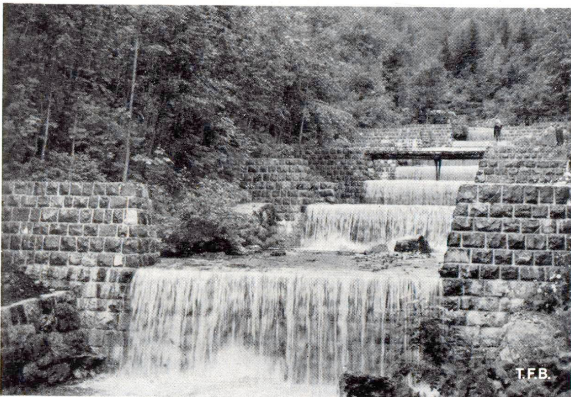
Fig. 2 Barrages en maçonnerie de pierres naturelles jointoyées au mortier de ciment portland. Correction du Dürrenbach, Stein, Toggenburg
