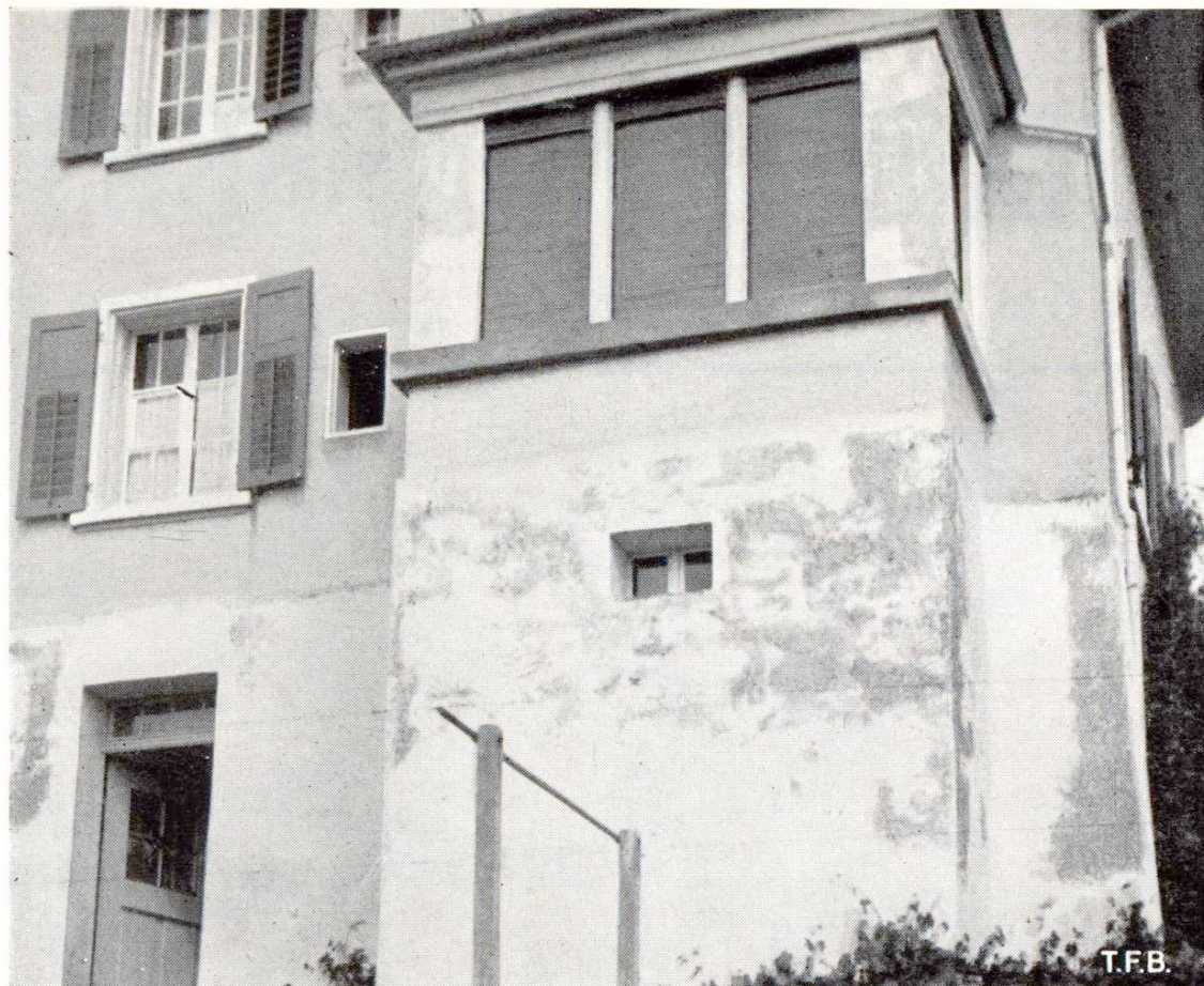
Fig. 1 Ecaillage d'une peinture à la chaux sur une fondation en béton et sur des enduits exposés
