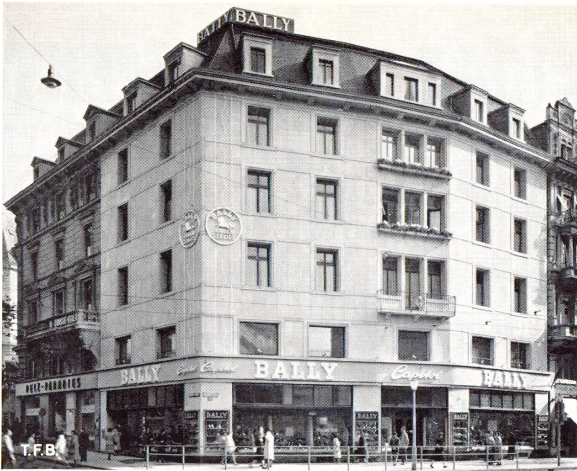
Fig. 2 Façade rénoverée par un revêtement en pierre naturelle. On remarque les cordons horizontaux supportant le poids du revêtement. A gauche, un ancien bâtiment avec mur à parement moellonné
