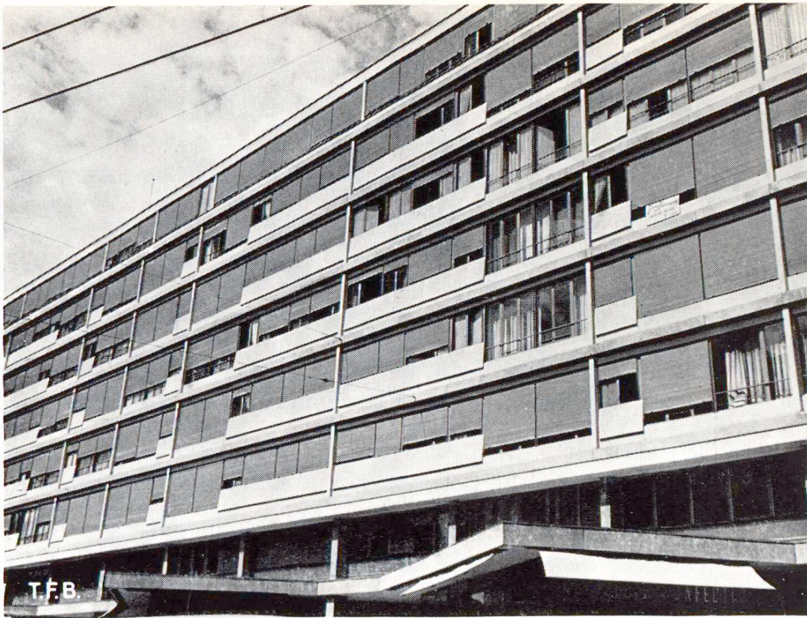
Fig.7 Immeuble moderne pour bureaux et logements à Genève. On a tiré parti de la forme complète des plaques de revêtement dont l'épaisseur est visible et permet un effet de relief
