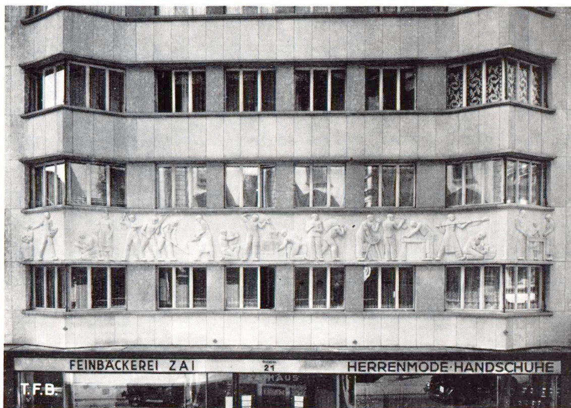
Fig 1 Revêtement de façade et bas-reliefs en pierre artificielle
