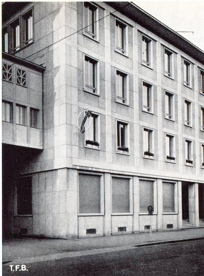
Fig. 6 Façade du bâtiment administratif de la direction des Téléphones à Lucerne. Le revêtement de la façade met bien en évidence la structure portante de la construction (en pierre artificielle)
