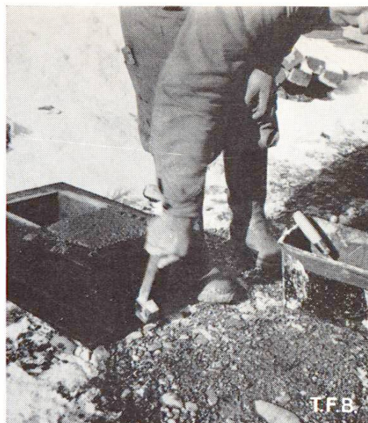
Fig. 6 On facilite la mise en place du béton en secouant légèrement le moule
