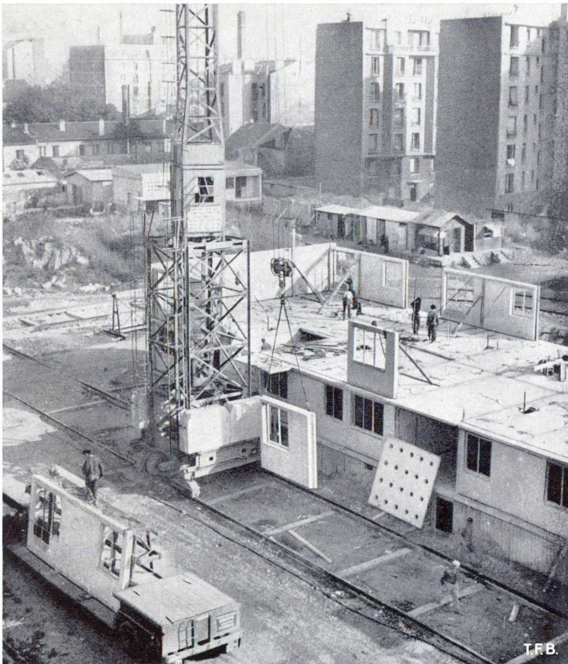
Fig. 5 Début du montage. Au premier plan, une des remorques spéciales pour le transport des éléments préfabriqués.
