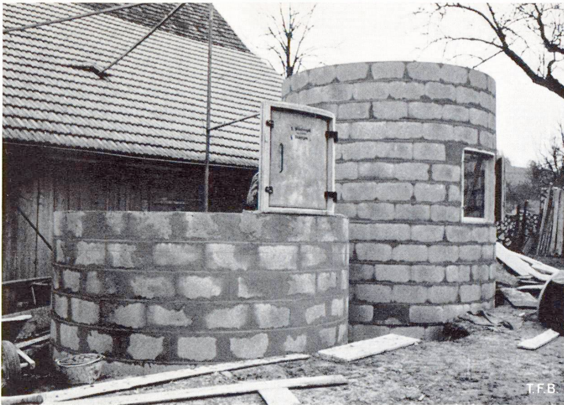
Fig. 3 Construction de silos en éléments préfabriqués
