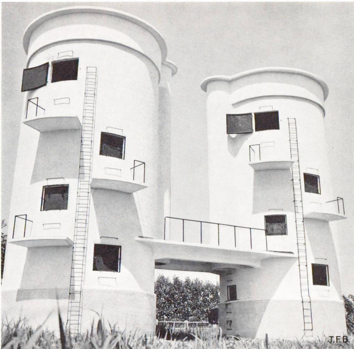
Fig. 9 Groupe de silos tour avec dévaloir à fourrage
