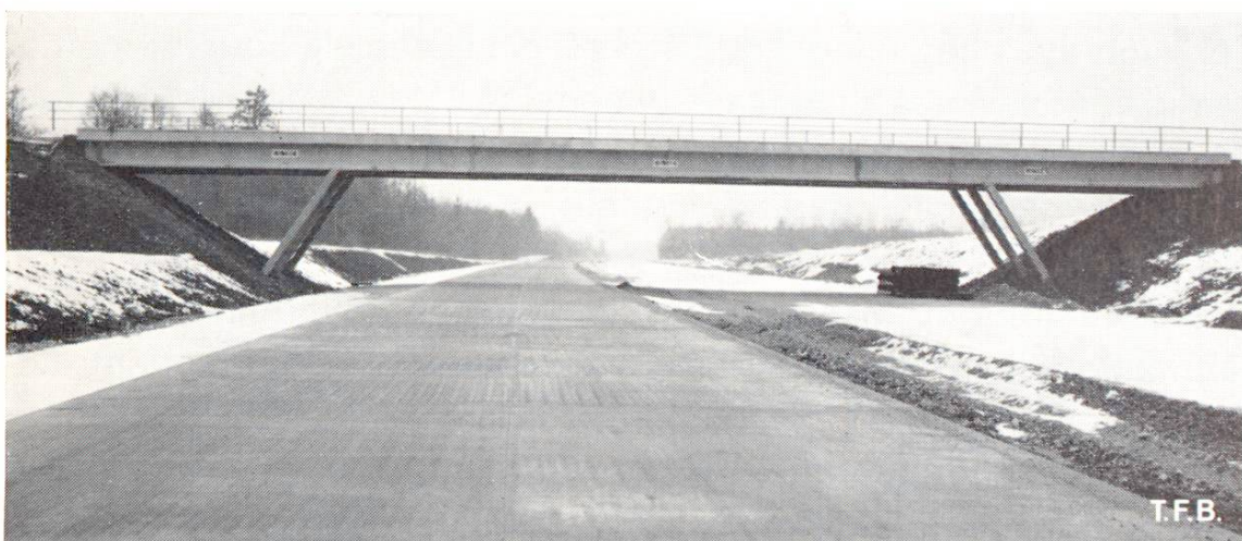
Fig. 4 Un pas en avant: Les ponts préfabriqués en série et montés pour les passages supérieurs de routes d'améliorations foncières sur l'autoroute Genève-Lausanne. Projet: Soutter & Schalcher, ing. dipl., Zurich. Préfabrication: Igéco S.A., Etoy VD.
