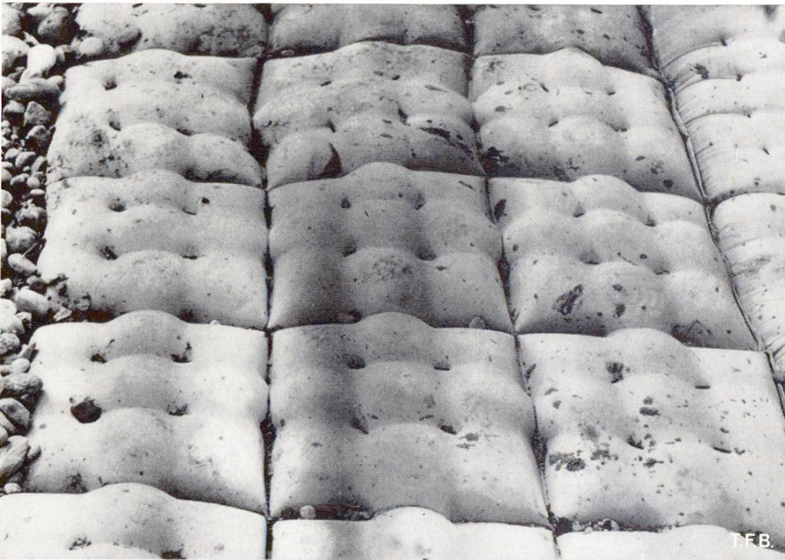
Fig. 5 Natte souple en béton Colcrete.
